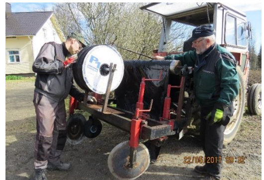
Kuvio 15. Muovi- ja tihkuletkurullien asentaminen muovinlevityslaitteeseen
