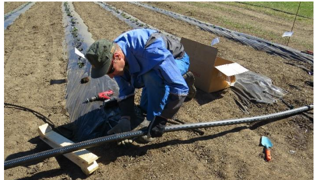
Kuvio 23. Veden runkolinjan asennus
