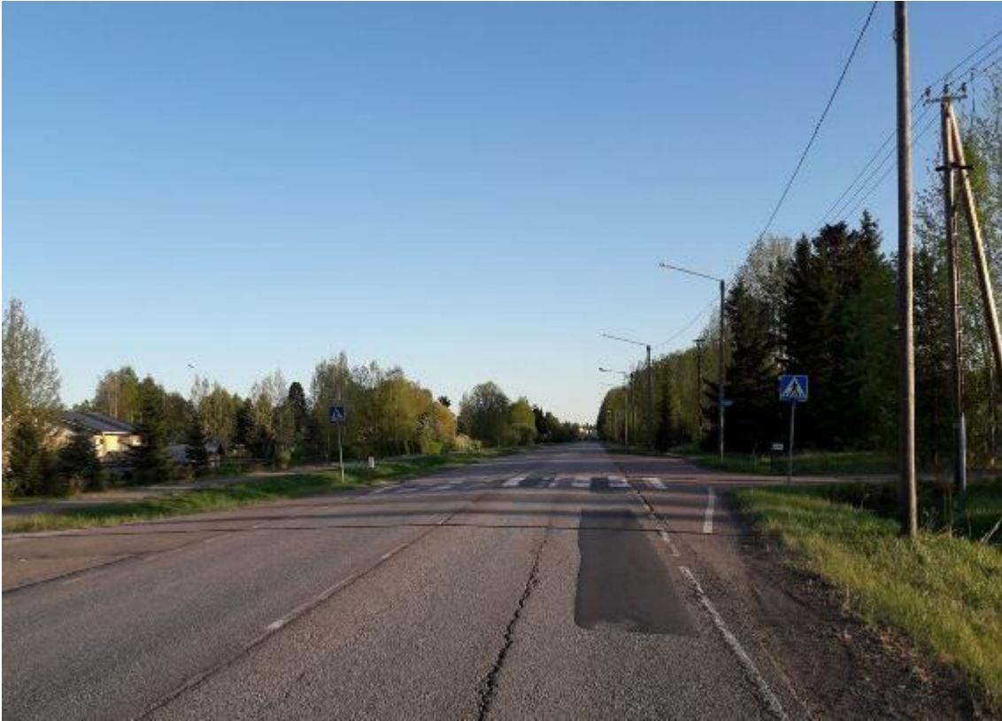
Kuva 4. Saarekkeeton suojatie pohjoisesta kuvattuna.
