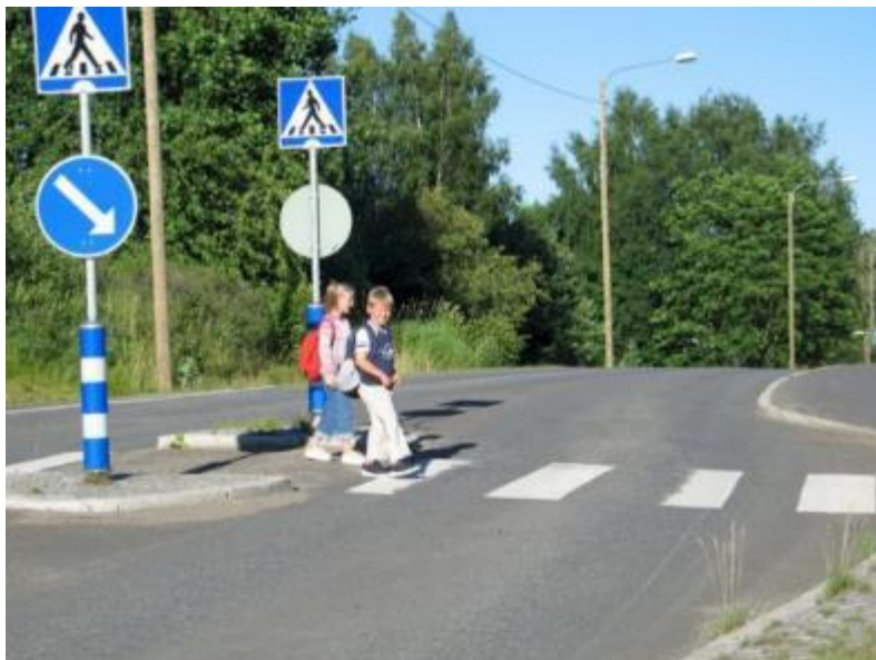
Kuva 3. Heijastevarret ja kaksipuoliset suojatie –liikennemerkkit. (Liikenneturva 2012)
