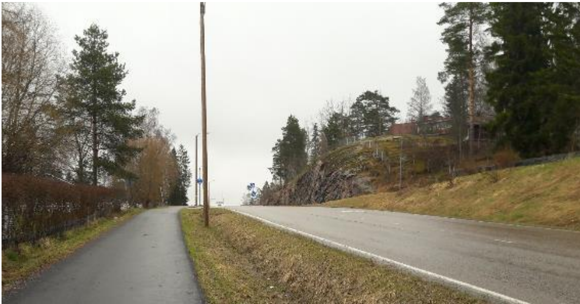
Kuva 9. Lähestyminen suojatietä etelästä. Suojatie on kukkulan päällä ja heikosti havaittavissa.
