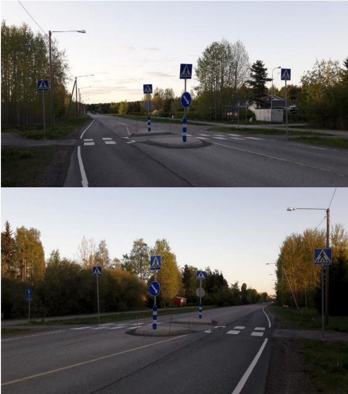
Kuva 5. Saarekkeellinen suojatie etelästä (ylempi) ja pohjoisesta (alempi) kuvattuna.
