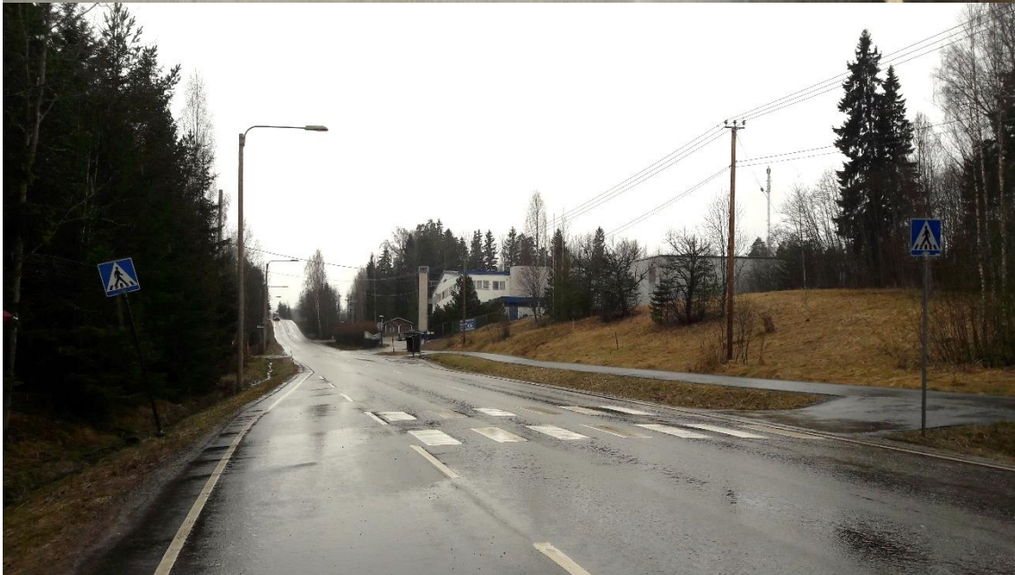
Kuva 8. Saarekkeeton suojatie etelästä (ylempi) ja pohjoisesta (alempi) kuvattuna.
