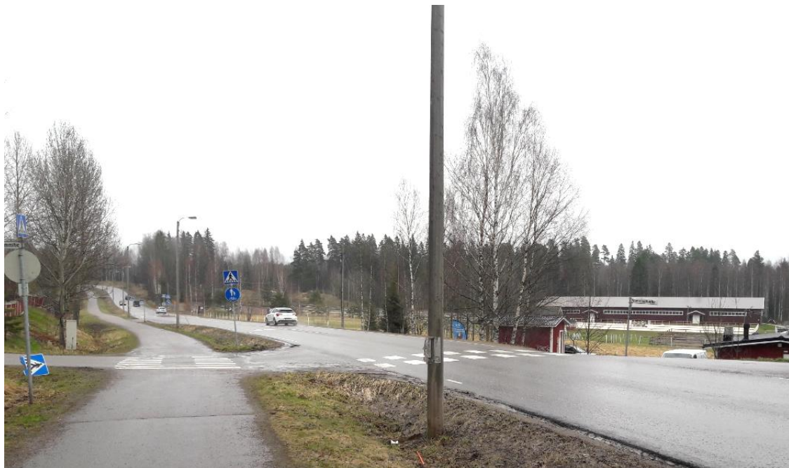
Kuva 14. Saarekkeeton suojatie lännestä kuvattuna.
