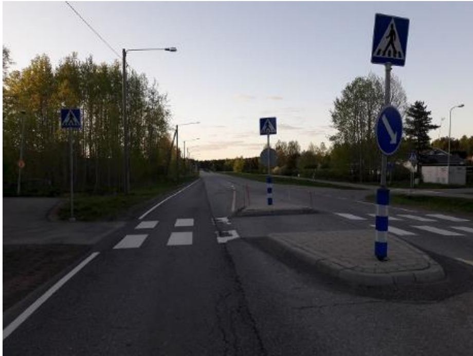
Kuva 4. Suojatiemerkein ja ajoratamaalauksin varusteltu keskisaarekkeellinen suojatie.
