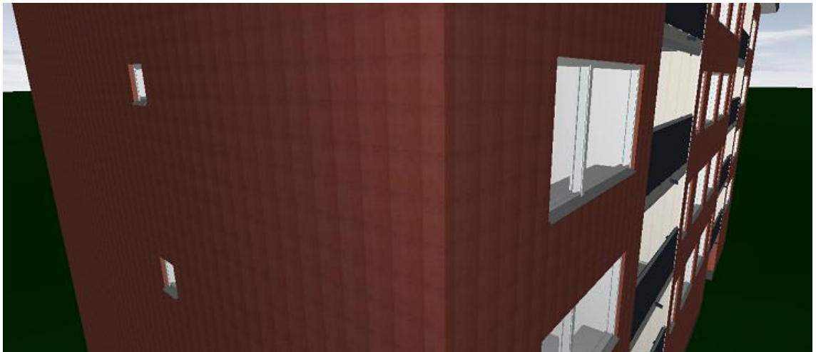
Kuva 6. Rappauksen pintakäsittelyn mallityö ulottuu nurkan yli kahden eri ilmansuunnan puolelle [1].
