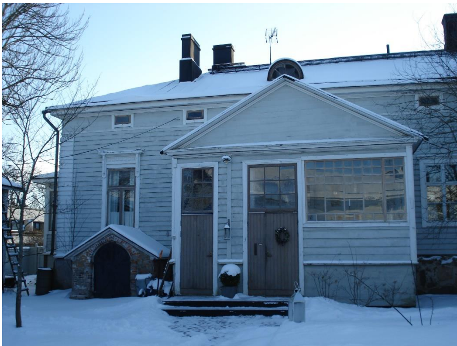
Bild 13. Utbyggd farstu och vågrät brädfodring på Lebedeffska handelsgården.
