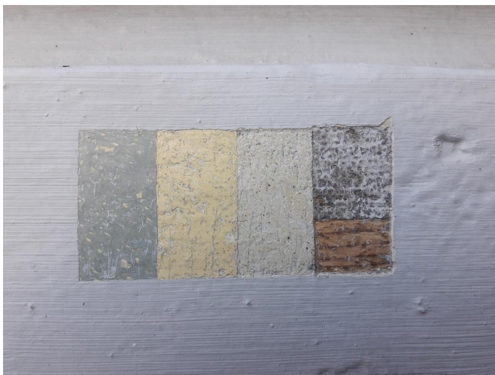
Bild 11. Den färdiga färgtrappan blev inte stor, knappt 10x5 cm. På den stora väggytan märks den inte om man inte vet var man ska leta.
