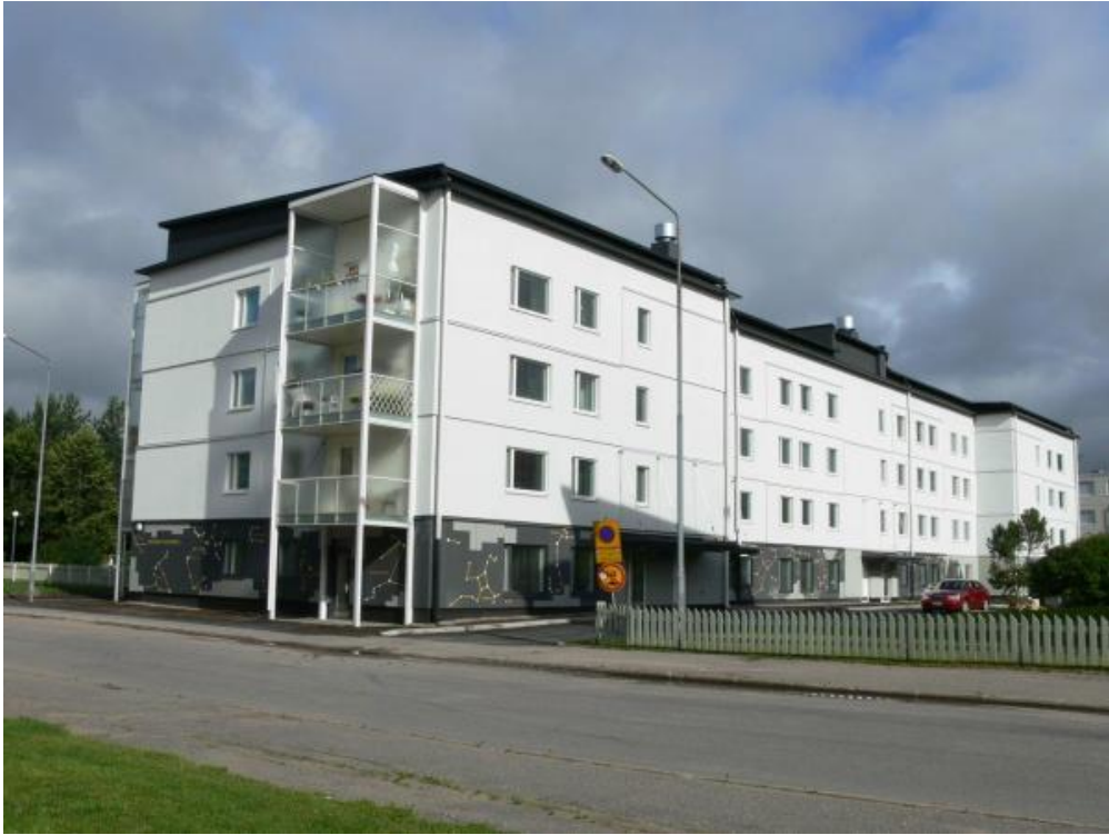
KUVA 2. Saturnuksenkatu 2 peruskorjauksen jälkeen (12)
