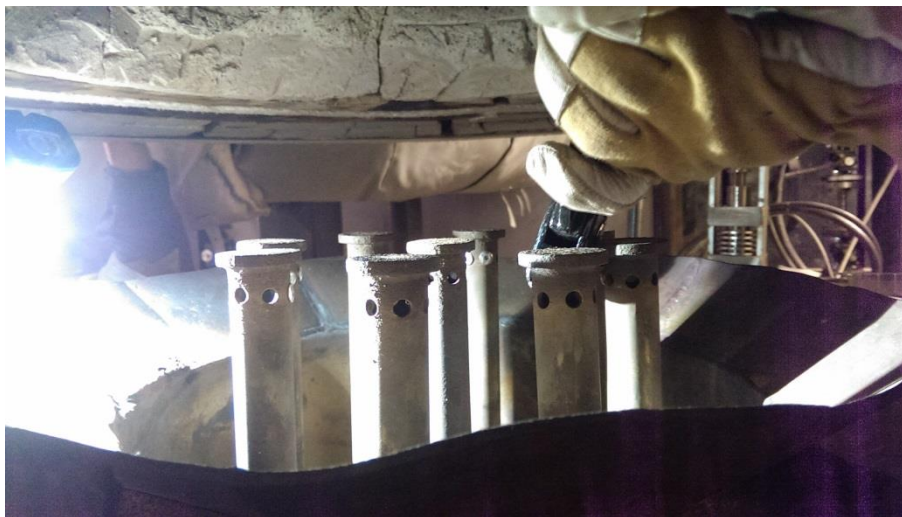
Kuva 4. Ilmasuuttimien niittaus
