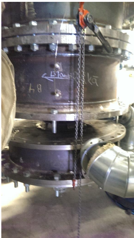
Kuva 3. Ilmalaatikon avaus ja puhdistus
