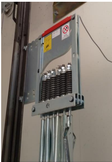
KUVA 7. Kannatinköysien ripustuspiste (Kuva: Rami Koskinen 2018)
