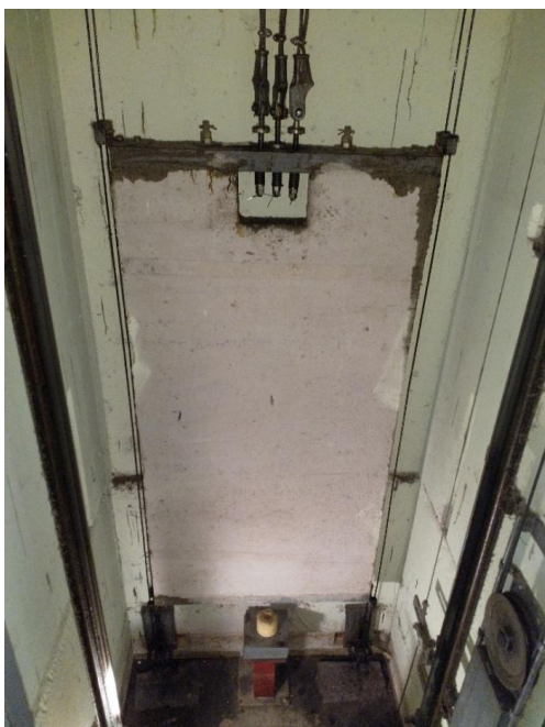
KUVA 9. Vastapaino (Kuva: Rami Koskinen 2018)
