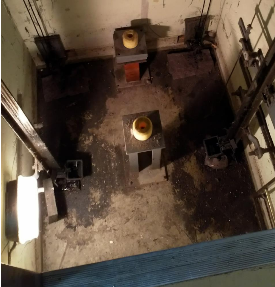
KUVA 11. Puskurit kuilun pohjalla (Kuva: Rami Koskinen 2018)
