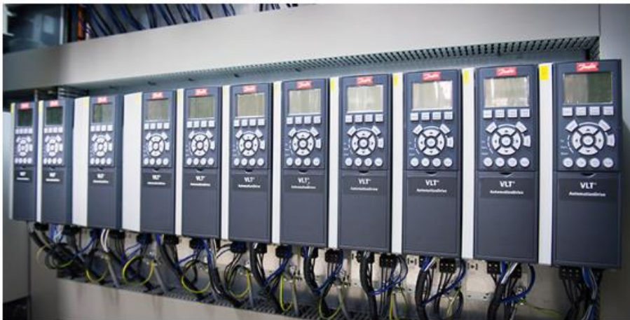
KUVA 13. Taajuusmuuttajia IV-tilassa (21.)
