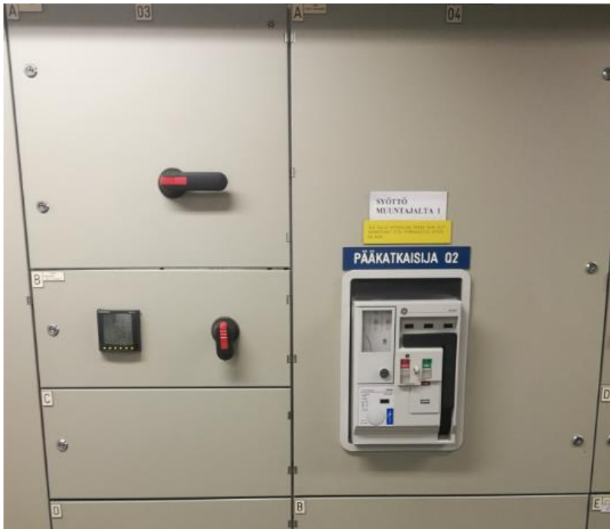
KUVA 7. Pääkatkaisija (kuva: Matias Wiena)
