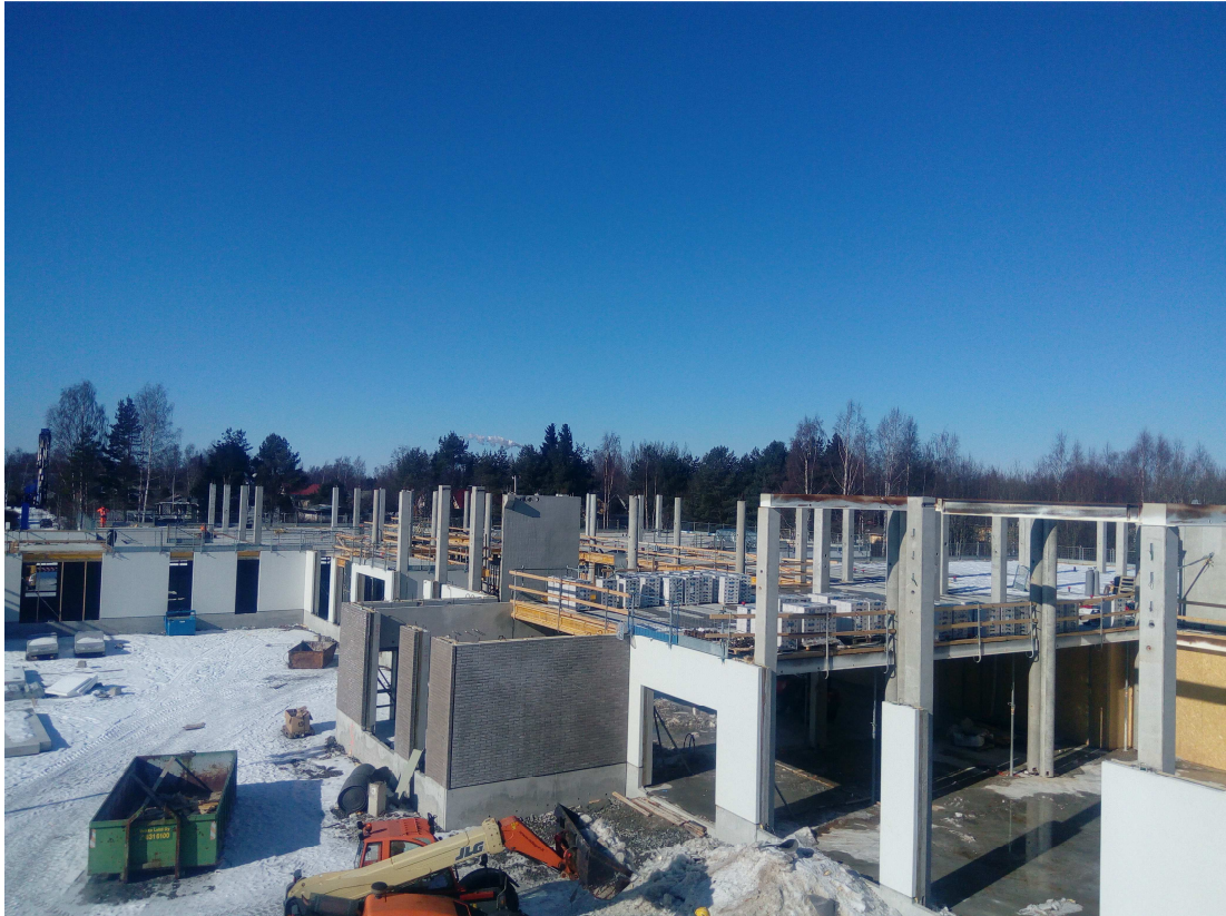
Kuva 1. Kuva Itä-Porin oppimis- ja liikuntakeskuksen rakennustyömaasta runkovaiheessa.
