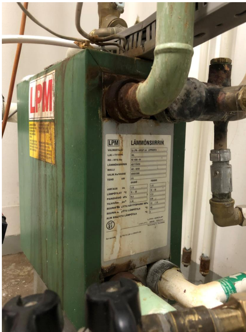
Kuva 2. Vanha käyttöveden lämmönsiirrin.
