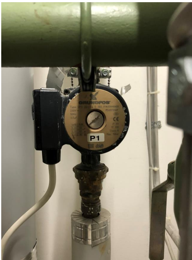
Kuva 5. Vanha käyttöveden pumppu.
