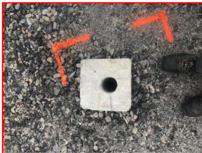
Kuva 3. Betonipaalu (R. Lautkankare, henkilökohtainen tiedonanto 13.11.2017).
