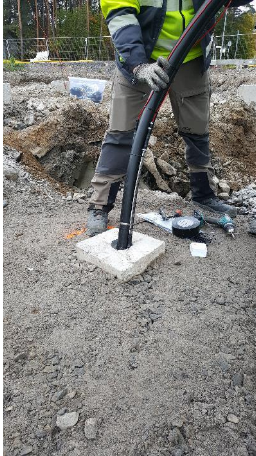
Kuva 7. Lämmönkeruuputken asennus betonipaaluun (R. Lautkankare, henkilökohtainen tiedonanto 13.11.2018).
