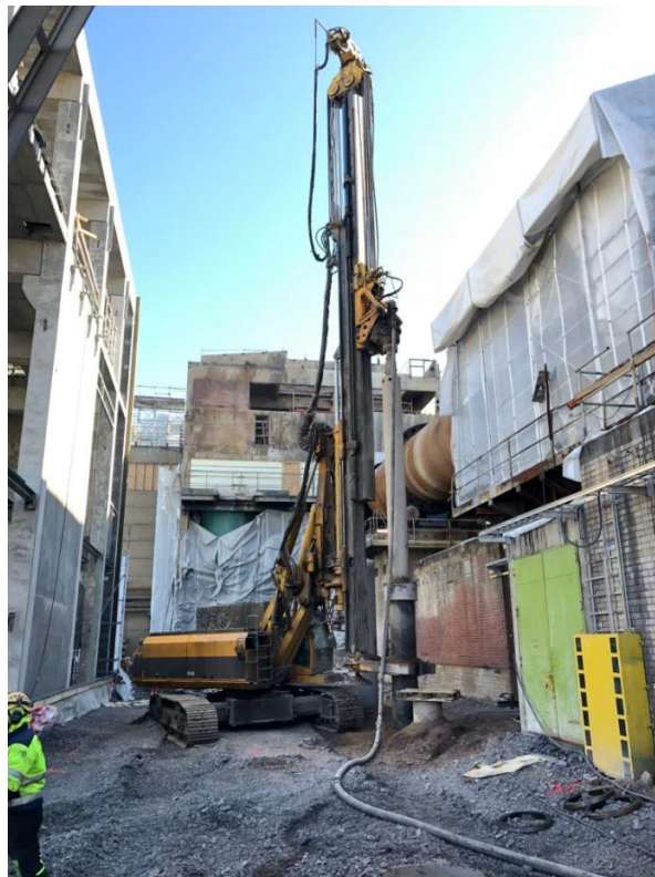
Kuva 4. Porapaalu (P. Paju, henkilökohtainen tiedonanto 15.4.2018).
