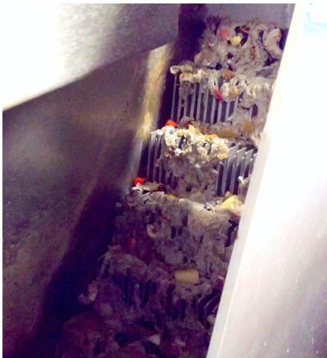
Kuva 2. Porrasvälppä (koneellisesti toimiva) Ristiinan jätevedenpuhdistamolla (Hedman 2018)
