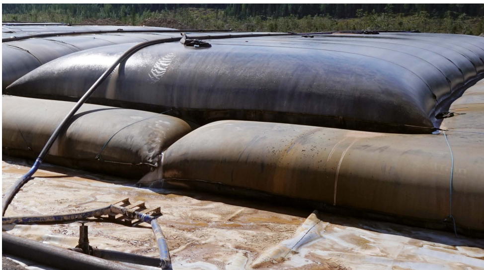
Kuva 4. Geotuubi on valmistettu kestävästä ja venyvästä materiaalista (Kaitos 2018)
