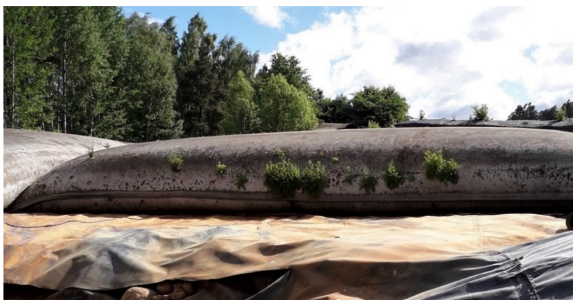
Kuva 6. Ankkapuiston ruoppausmassat on säilötty geotuubeihin. (Kuva K.Kannisto).
