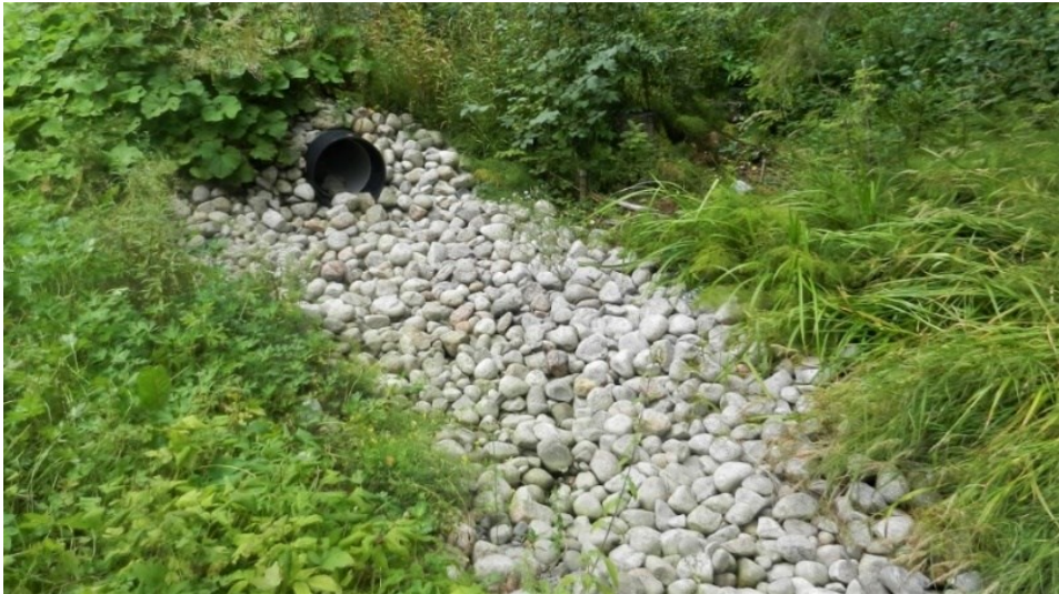
Kuva 8. Ankkapuiston hulevesiä puhdistetaan viivytyrakenteilla. (Kuva K.Kannisto).
