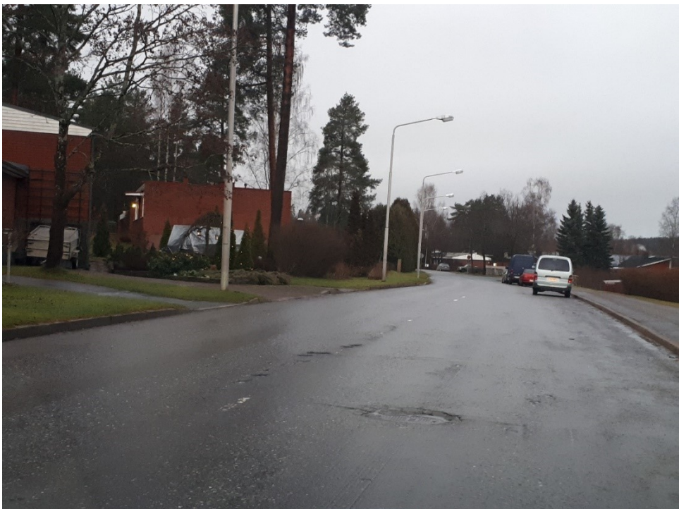
Kuva 6. Erilaisia päällystevauriota, kuten reikiä.
