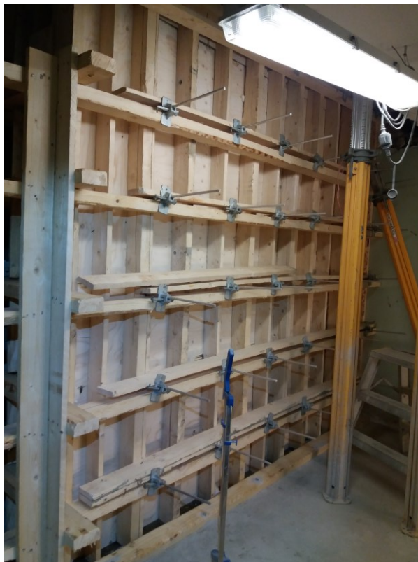
Kuva 15. Hissikuilun muotti -2. Kellarikerroksessa (Kämppi 2018).
