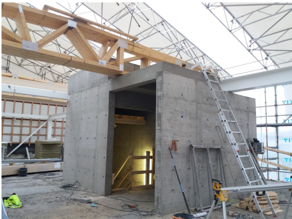
Kuva 23. 7. kerroksen valmis hissikuilu, yläkuppi ja hissien aulatila (Kämpö 2018)
