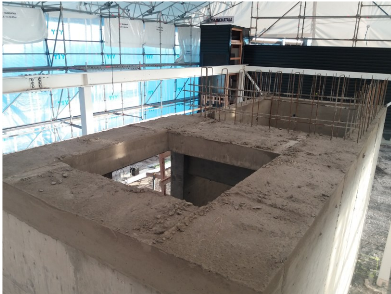
Kuva 21. Hissikuilun kulkuaukko vesikatolle ja tartuntaraudat yläkupille (Kämppi 2018).
