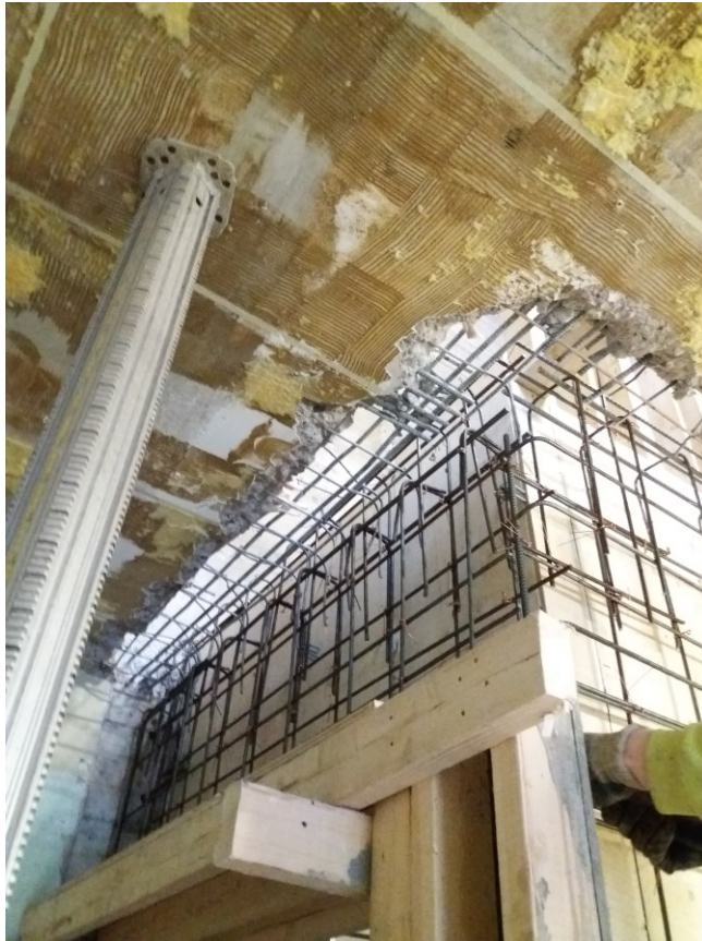
Kuva 19. Hissikuilun palkin raudoitus sekä liitos vanhan holvin raudoitukseen (Kämppi 2018).
