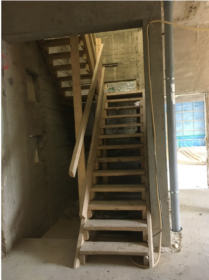
Kuva 24. Väliaikainen kulku 6. - 7. kerrokseen (Kämppi 2018).
