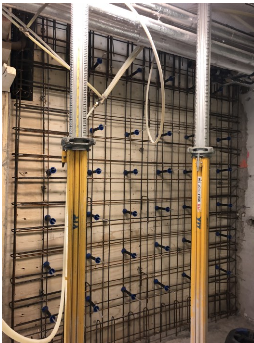
Kuva 16. Hissikuilun seinäraudoitus -2. kellarikerros (Kämppi 2018).
