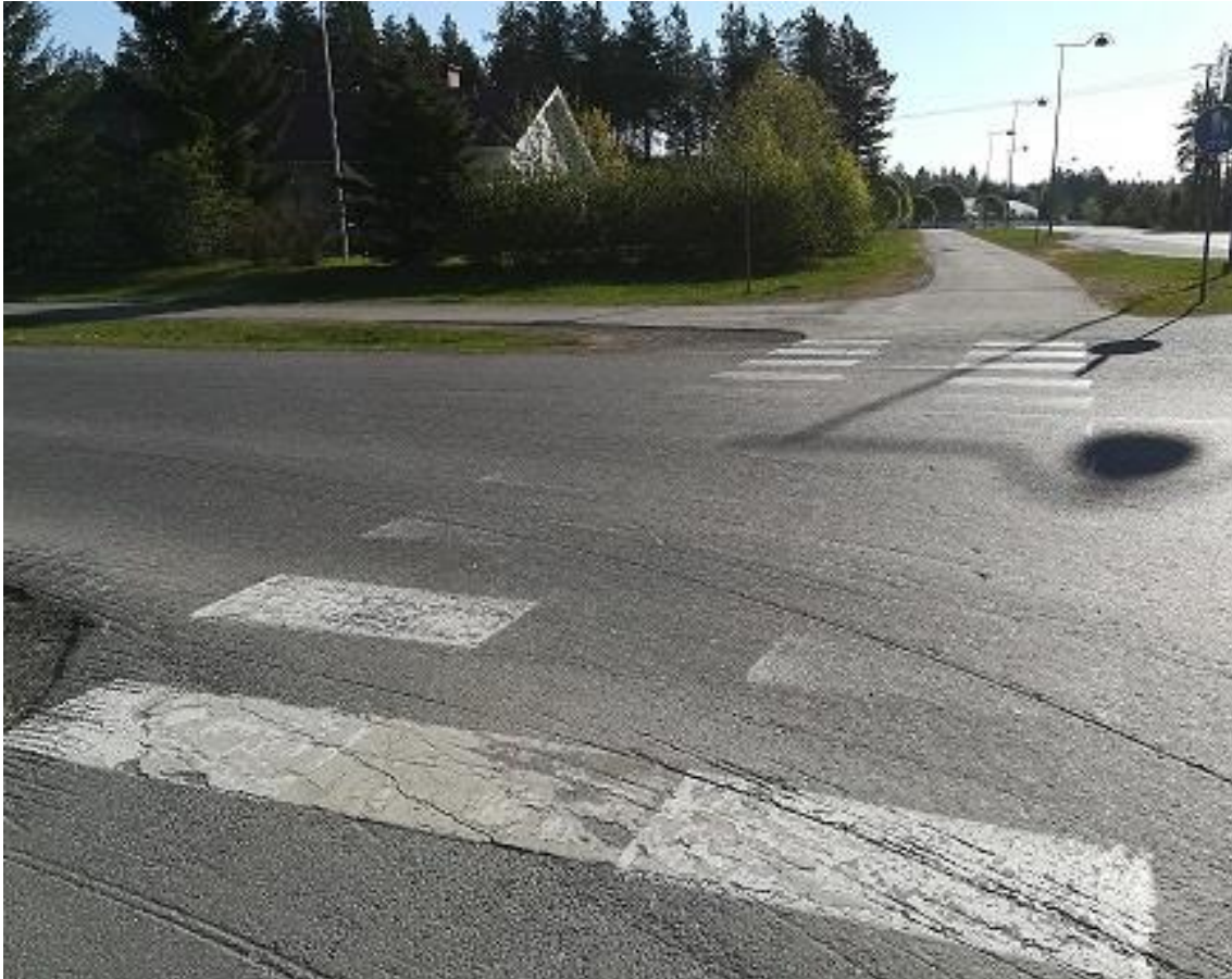
KUVA 6. Maalimerkityt suojatiet talven jälkeen.
