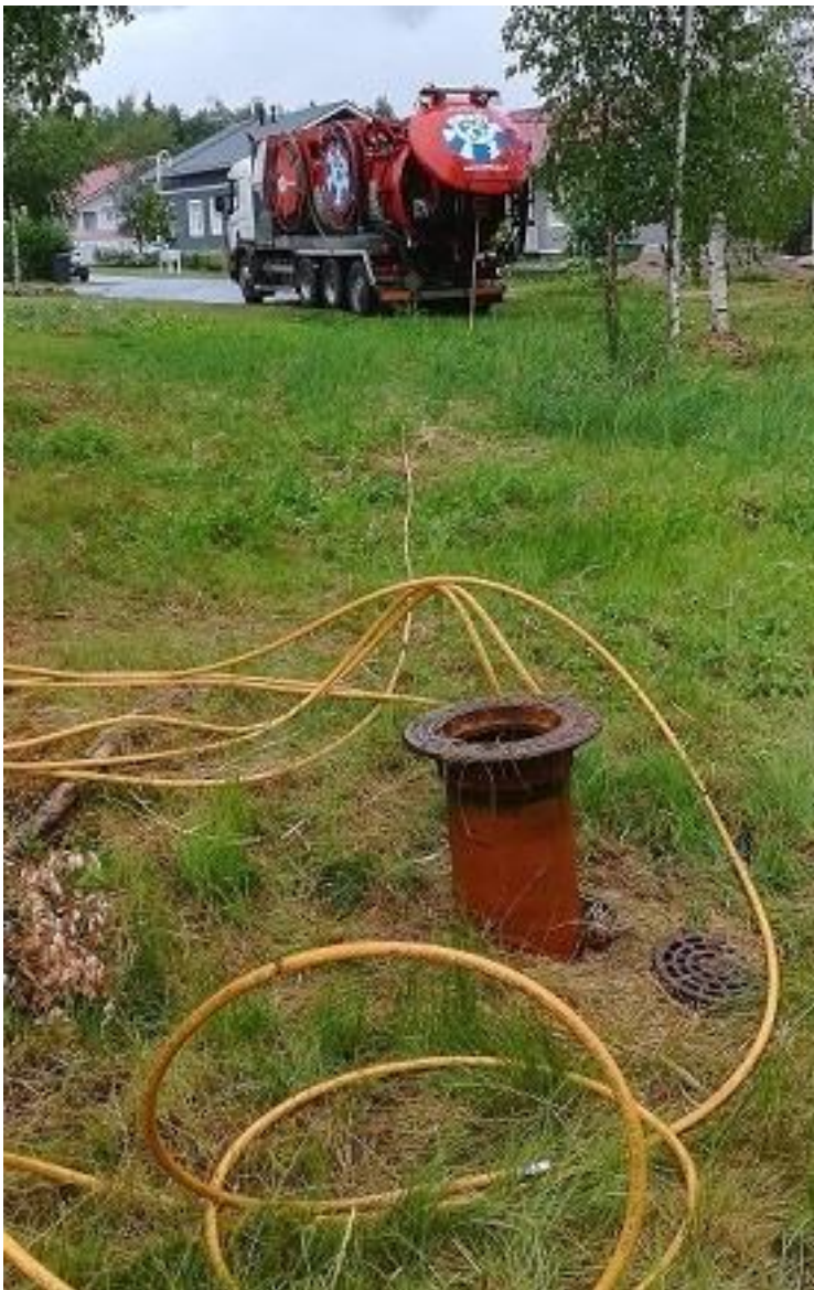
KUVA 5. Hulevesiverkon huuhtelutoimenpide Niittyrannan asuinalueella
