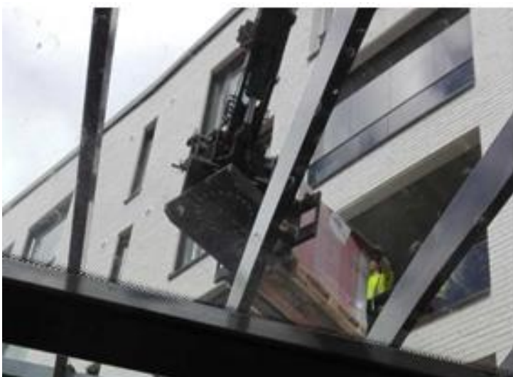
Kuva 1. Kurottajaan kytketty lisälaitte. 360 astetta pyörivät trukkihaarukat - ns. "rotopiikit"
