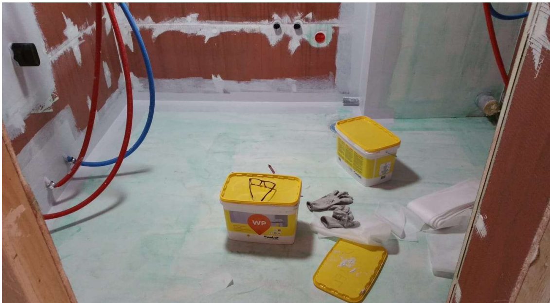
Kuva 10 Nurkkavahvikenauhojen asennus käynnissä
