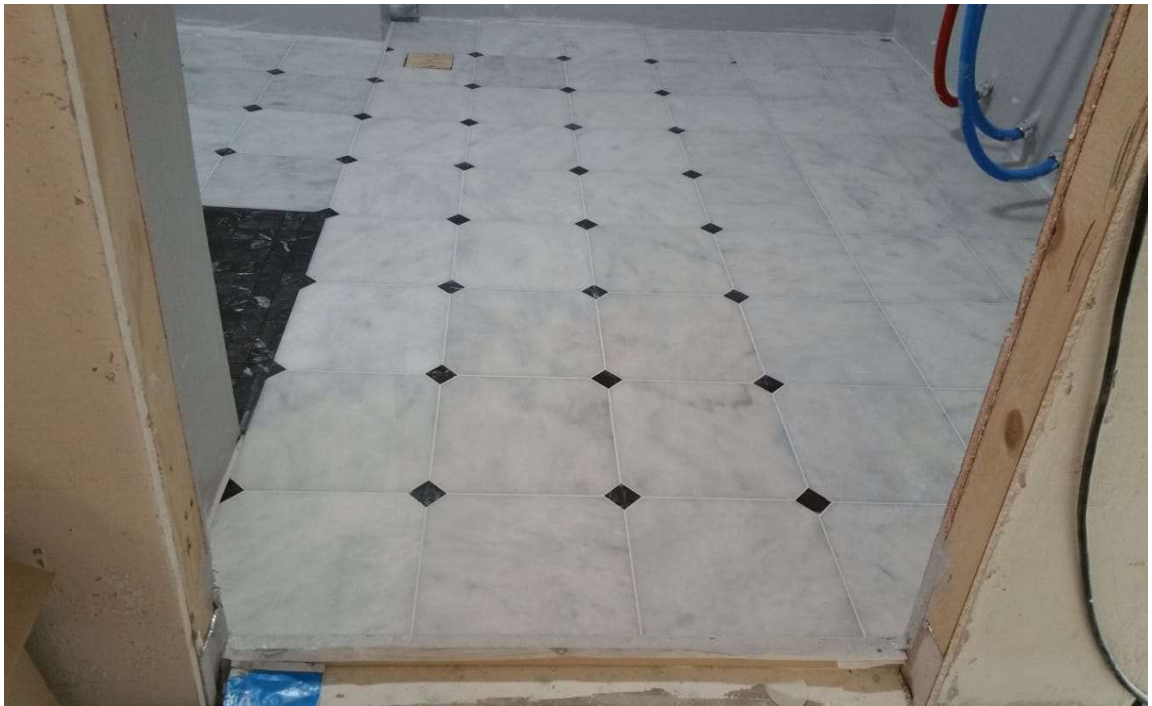
Kuva 12 Valmis lattialaatoitus
