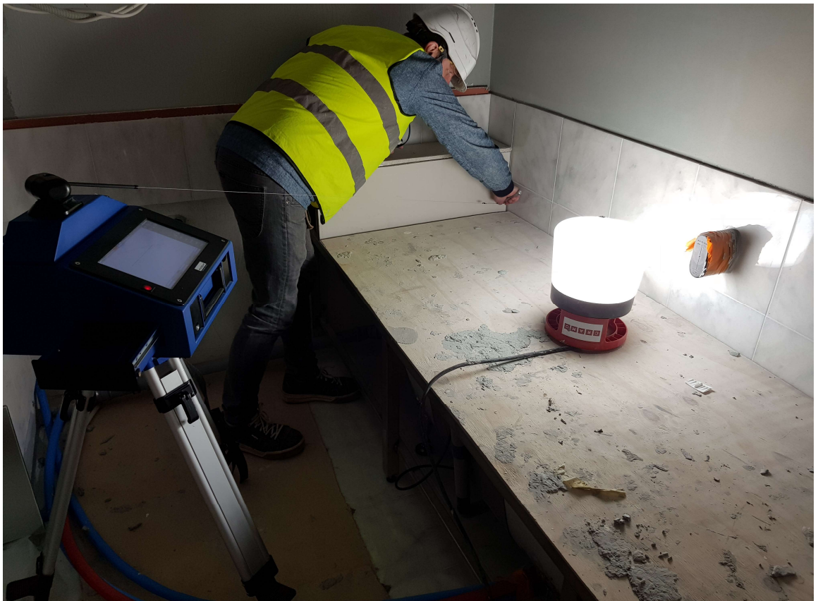
Kuva 16 Ammekiven mitoitus käynnissä
