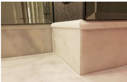
Kuva 11 Jiiriin laatoitettavia marmorikiviä
