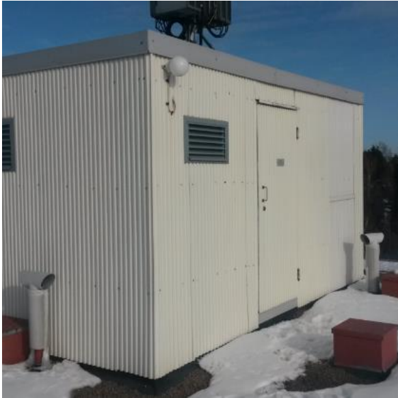
Kuva 16. Emännänraitti 4 Hissikonehuone vesikatolla
