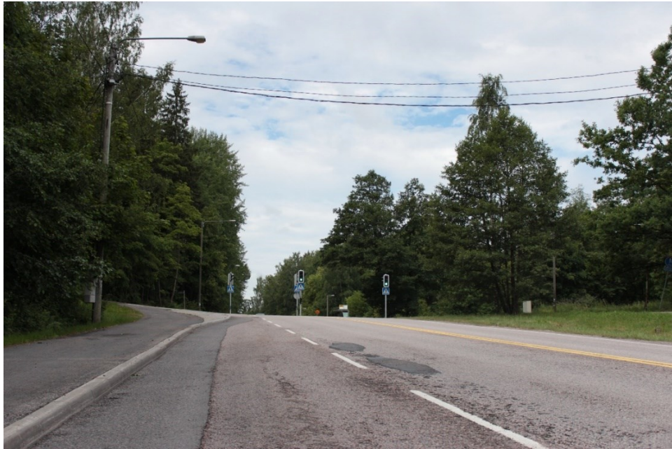
Kuva 28. Turuntie – Vanha Turuntie -liittymäkohta Bembölen suuntaan. Vanha Turuntien liittymä on liikennevalojen vasemmalla puolella. (Pasanen 2018.)
