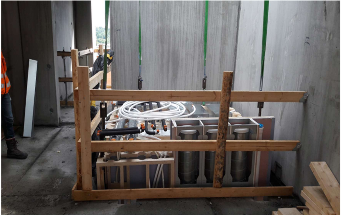
Kuva 1. Moduulin laskeminen kuilussa. Kuilun ympärillä putoamissuojana toimiva kai-de-elementti. (27.)
