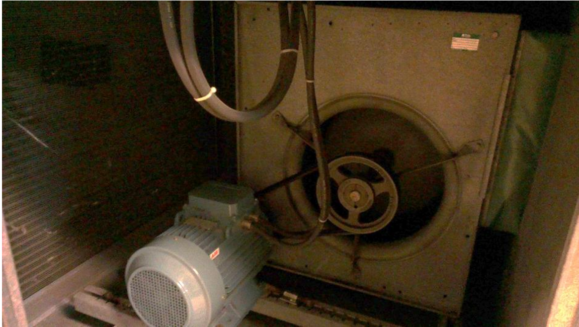
Figur 2 illustrerar de nuvarande kammarfläktarna i ventilationsaggregatet.
