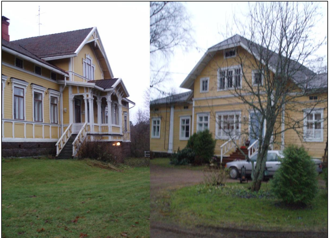
KUVIO 7. Kirkonkylän merkittävimpiä rakennuksia ovat muun muassa kuvassa näkyvät Kirkkoherran pappila vasemmalla ja empirerakennus Lepola oikealla.
