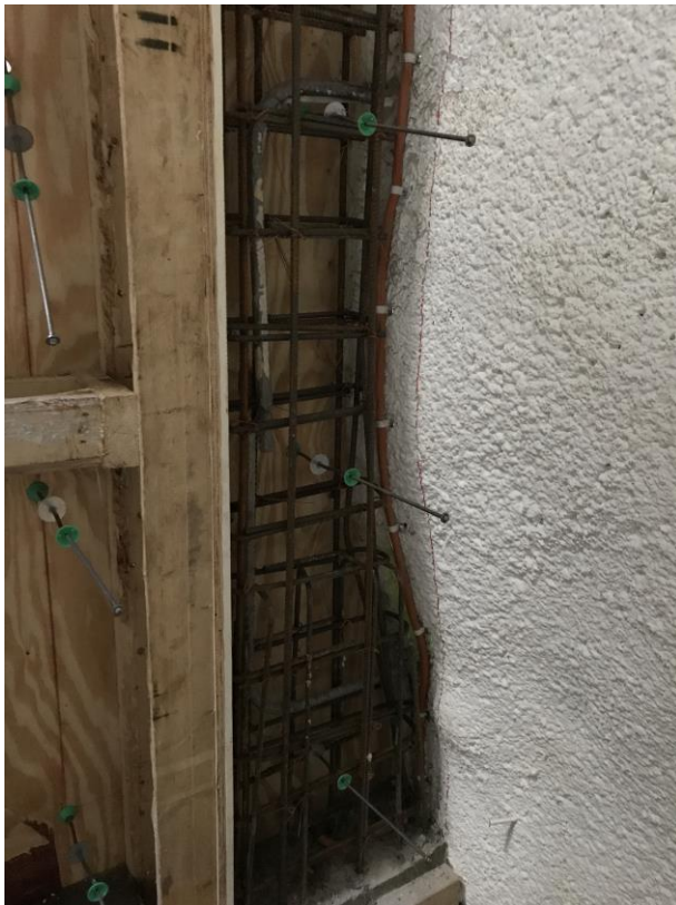
Kuva 1. Lauta- ja levymuotti, jossa raudoitus, kalliopultit, muottisiteet ja injektointiletku
