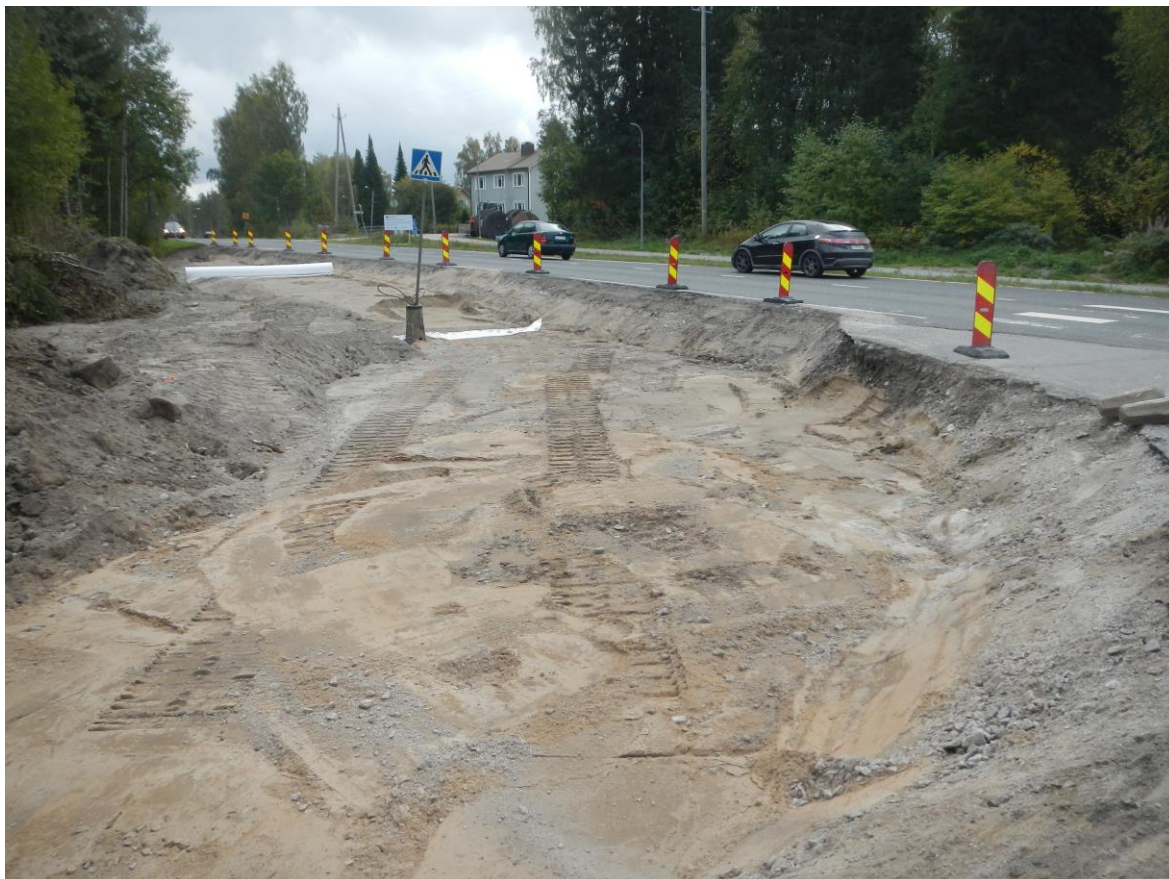
Figur 5. Grävningsarbetena utfördes med stora trafikmängder intill.
