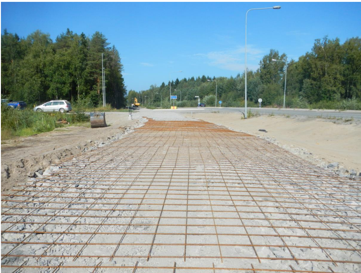
Figur 4. På grund av dåliga grundläggningsförhållanden monterades armeringar i bärlagret.
