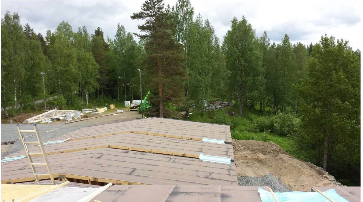
Kuva 5. Elementtien asennus jakautui kahdelle työvuorolle
