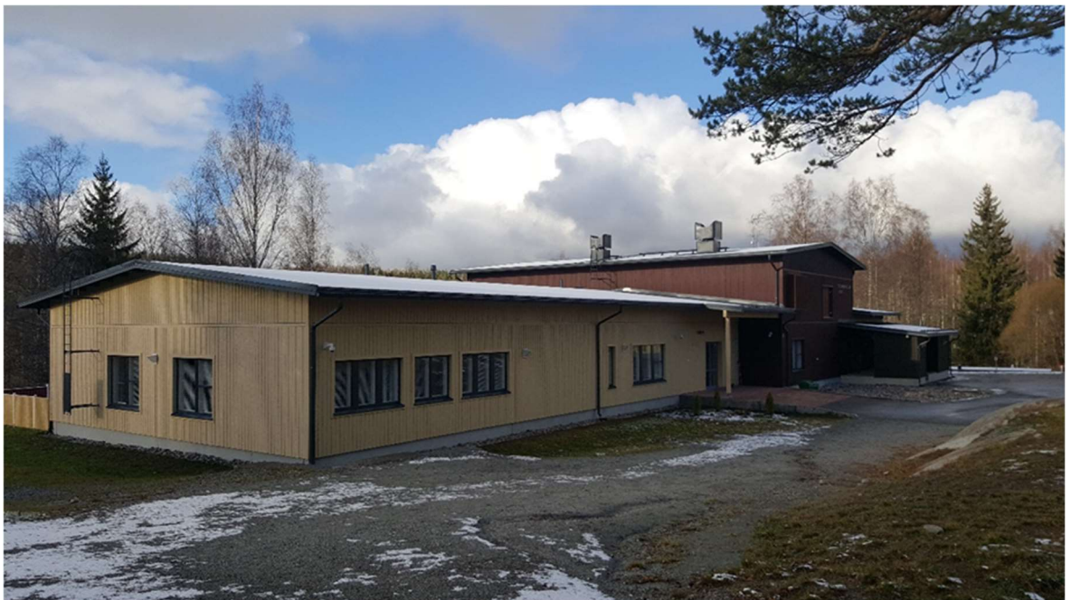
Kuva 1. Jukojärven uusi ala-asteen koulurakennus
