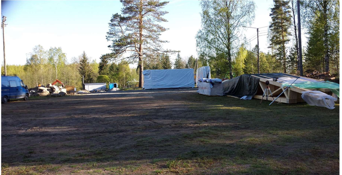
Kuva 2. Elementtien rakentamisalueena tasainen kivituhkakenttä
