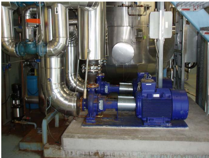
KUVA 16. Kaukolämpöpumput
