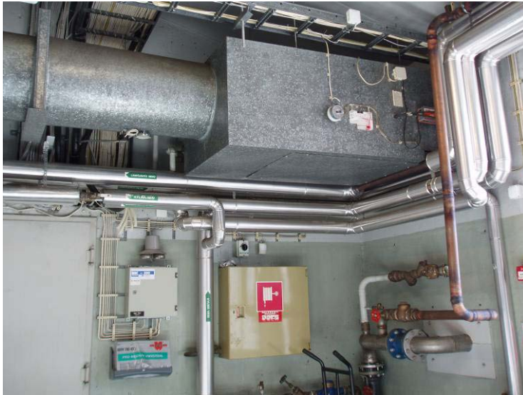
KUVA 21. Toimiston ilmanvaihtolaitteisto
