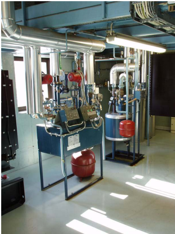
KUVA 18. Lämmönsiirtimet
