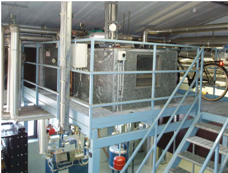
KUVA 19. Kattilahallin ilmanvaihtolaitteisto
