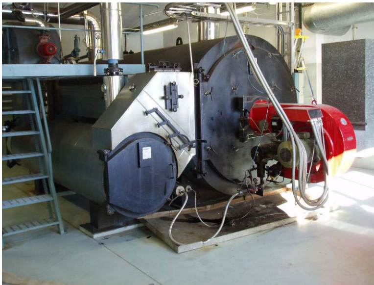
KUVA 15. Raskasöljypoltin Oilon RP-203H
