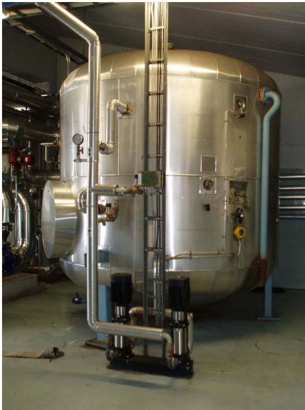
KUVA 17. Paisuntasäiliö
