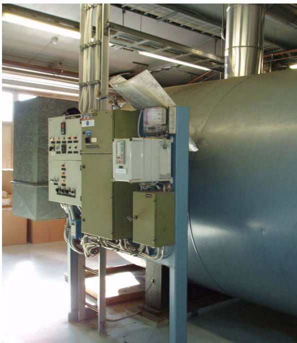
KUVA 24. Kattilan oma keskus, Kattila-OK
