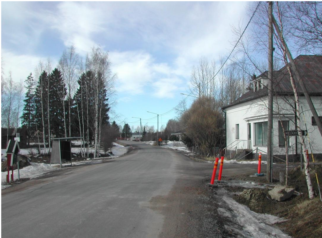
Kuva 4. Alapääntie Kyrönjoen ja valtatie 18 välissä Isonkyrön Valtaalan suuntaan. Kuva: Tero Jänis
