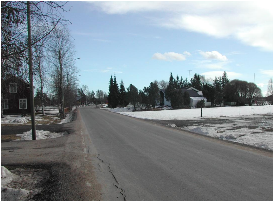
Kuva 3. Alapääntie Kyrönjoen ja valtatie 18 välissä Ylistaron keskustan suuntaan. Kuva: Tero Jänis
