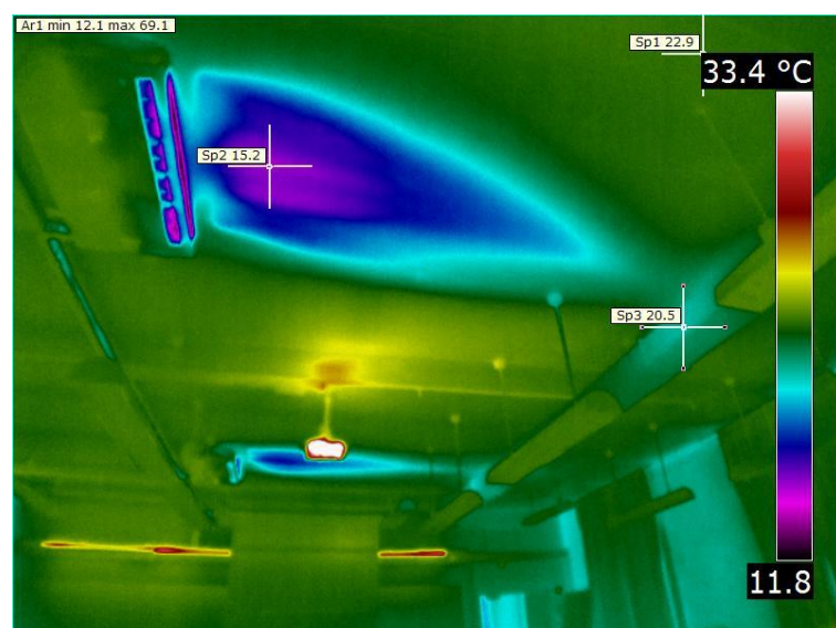
Kuva 42. Jäähdytyslaitteiden tarkistus ja suuntaus [30].
