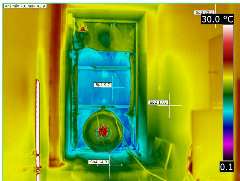
Kuva 47. Ilmatiivysmittauslaitteiston kuva rakennuksen sisäpuolelta [30].
