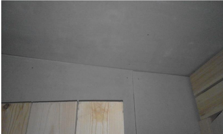
Kuva 2. Kattolevytystä asbestisementtilevyllä (Jari Kelokaski 2018)
