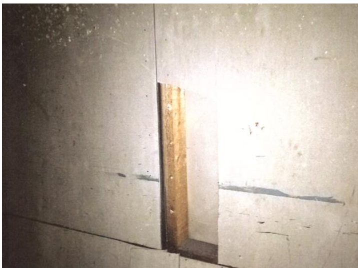
Kuva 1. Seinälevytystä asbestisementtilevyllä (RATEKO 2016)
