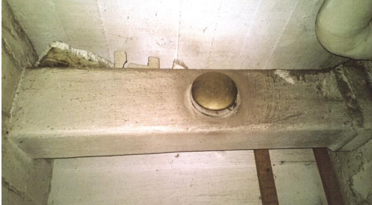
Kuva 5. Asbestisementtinen IV-kanava (RATEKO 2016)
