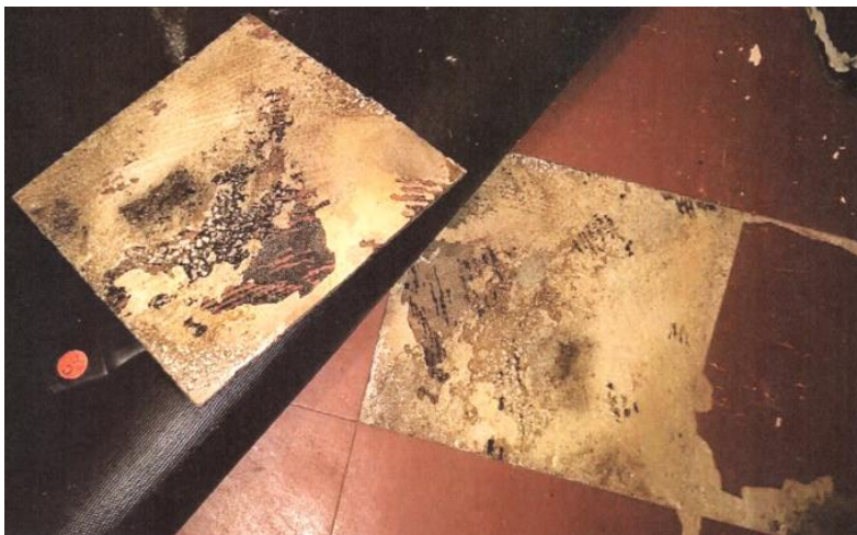
Kuva 8. Finnflex-laatta ja musta liima (RATEKO 2016)
