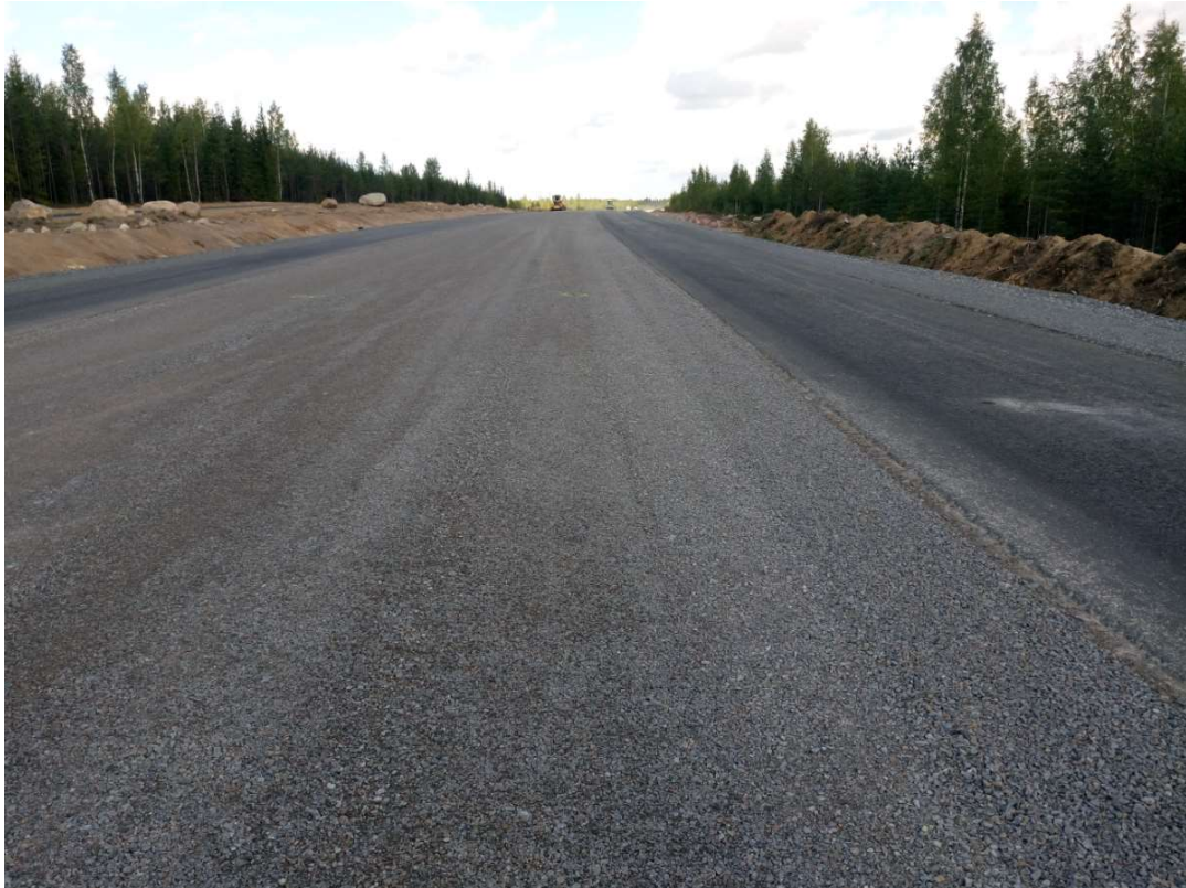
Kuva 2. Ohituskaistan valmis kantava kerros (Skanska Infra Oy)
