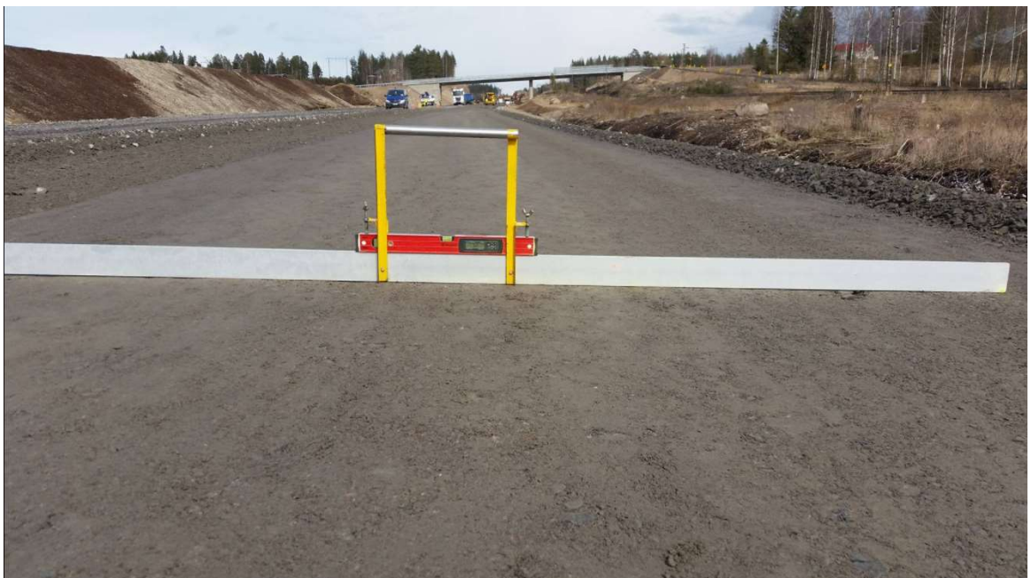
Kuva 5. Oikolautamittaus (Skanska Infra Oy)
