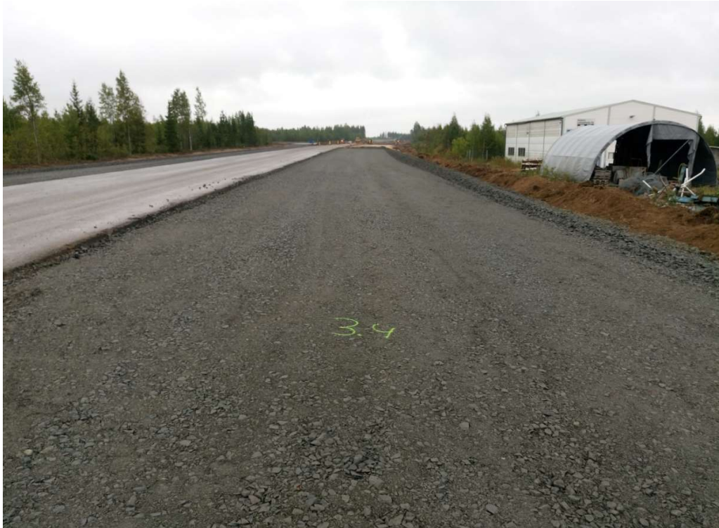
Kuva 8. Infrakit-kuva jossa kantavan kerroksen oikolautamittauksen tulos (Skanska Infra Oy)
