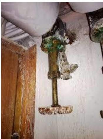
Kuva 4. Vanha vuotanut venttiili [2]
