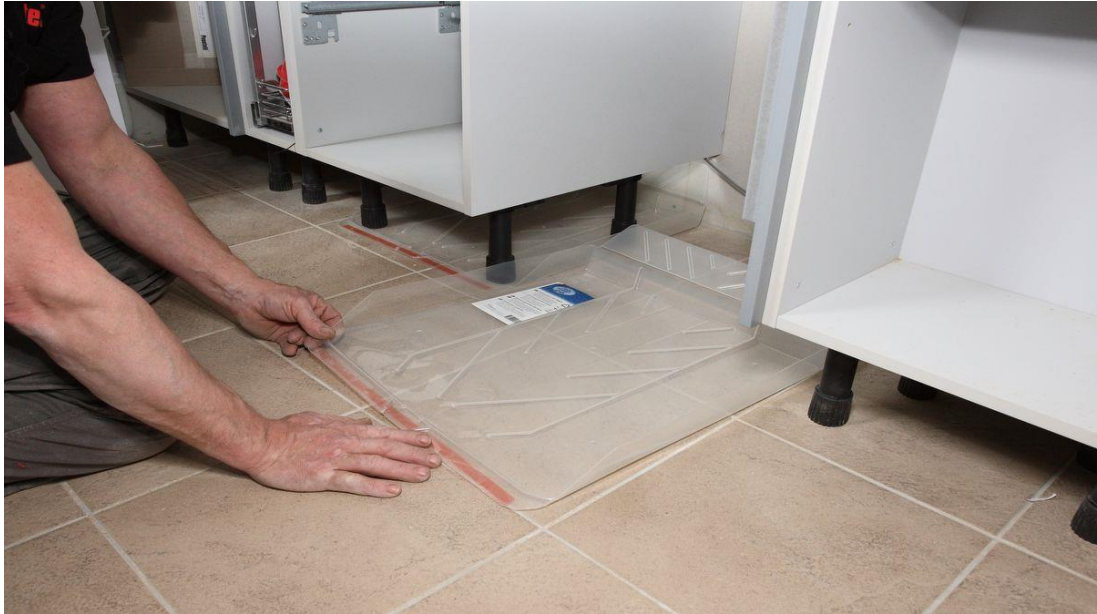
Kuva 1. Vuotokaukalo asennetaan pesukoneen alle
