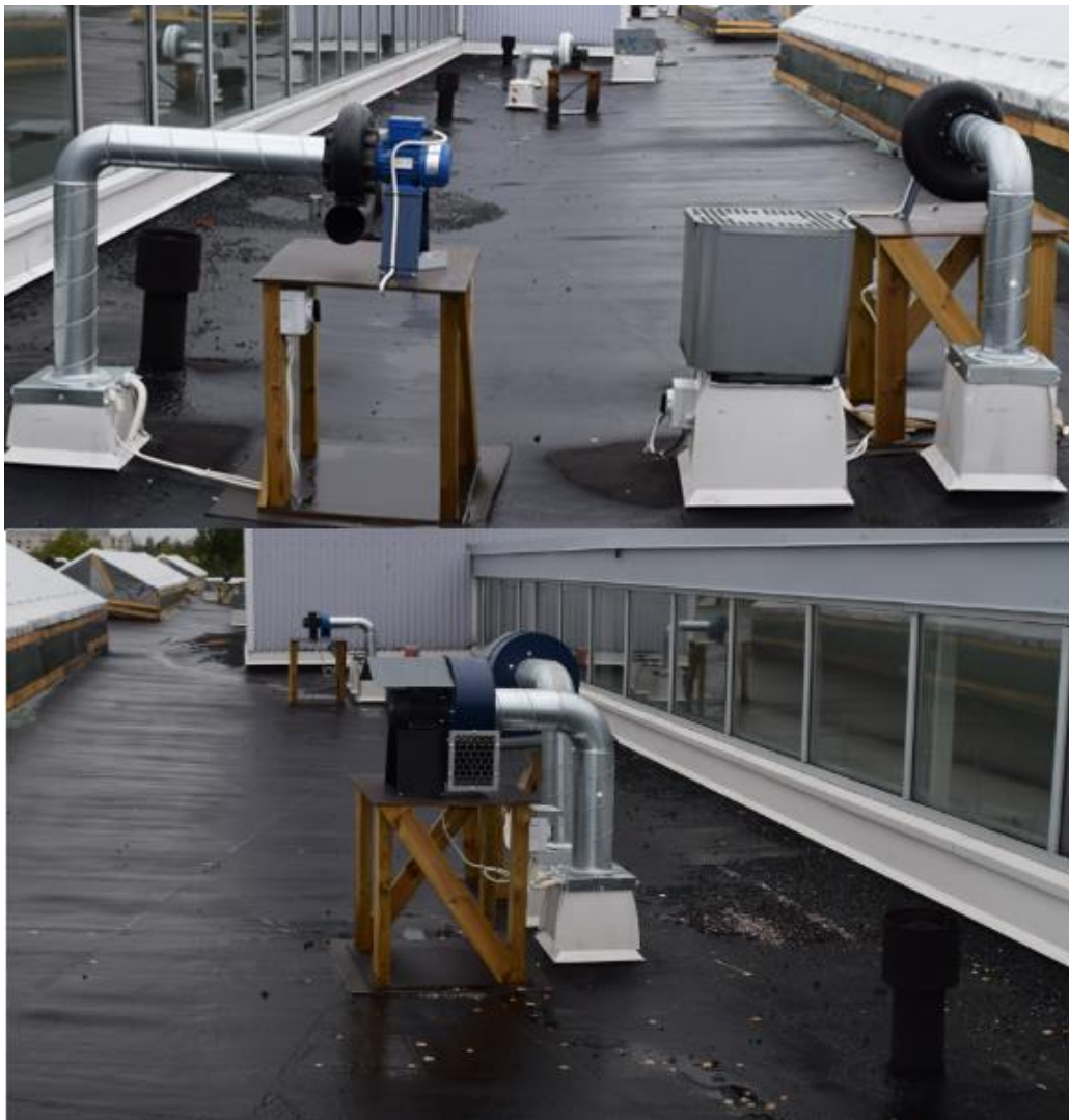
Kuva 5. Uusittuja poistoilmapuhaltimia vesikatolla.
