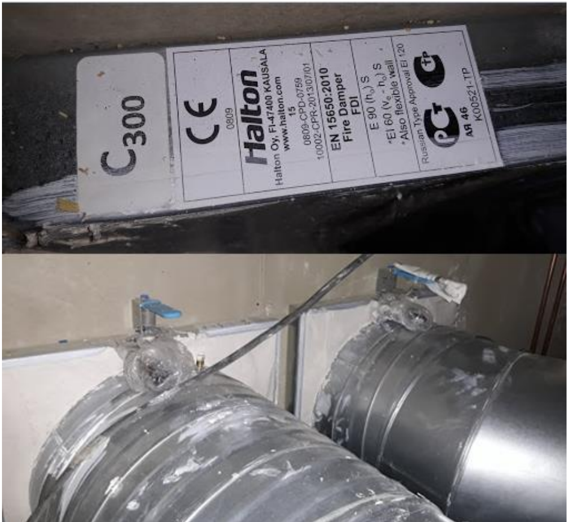
Kuva 4. Vasta-asennettuja EI60-luokan palopeltejä IV-konehuoneessa 1.
