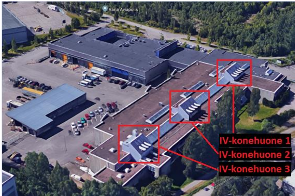
Kuva 1. Varia Aviapolis, vanhan osan IV-konehuoneiden sijainnit vesikatolla.
