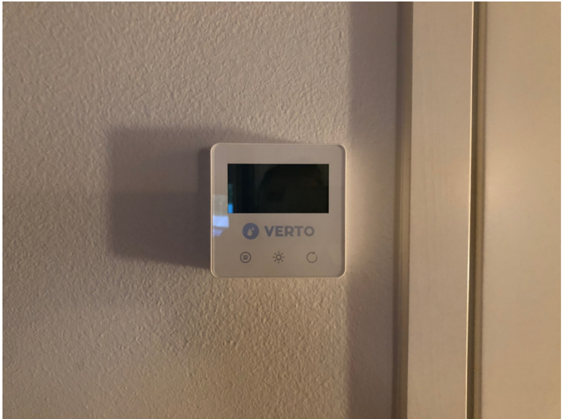
Kuva 3. Etäluettava huoneistokohtainen vesimittarinäyttö.
