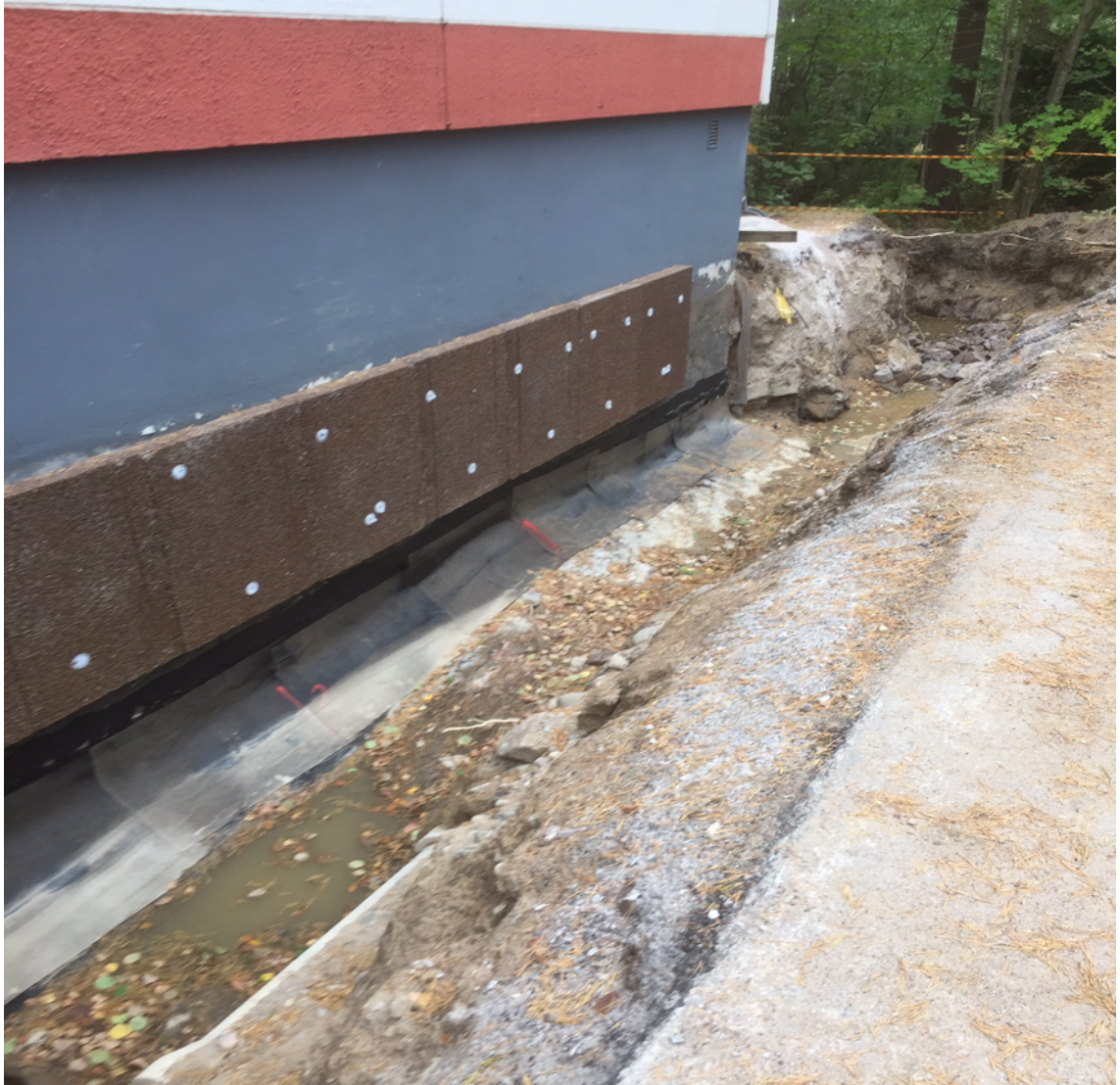
Kuva 8. 2. talon sokkelin vesieristys.
