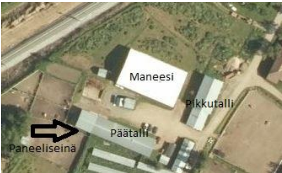
KUVA 9. Ilmakuva tallirakennuksista (Paikkatietoikkuna 2018)
