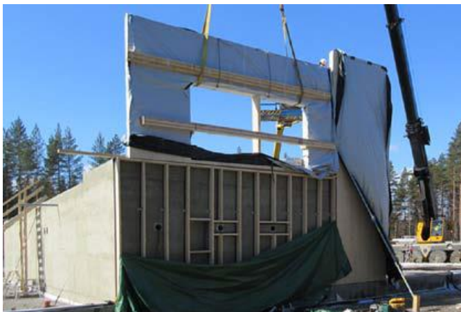
Kuva 18. CLT-elementti asennustyömaalla. (RT 21-11289).
