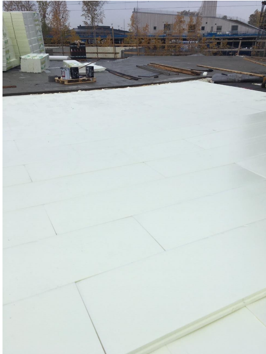
Kuva 4. Lämmöneristeet asennettuna. Kuvassa esitetään saumojen oikea limitys.
