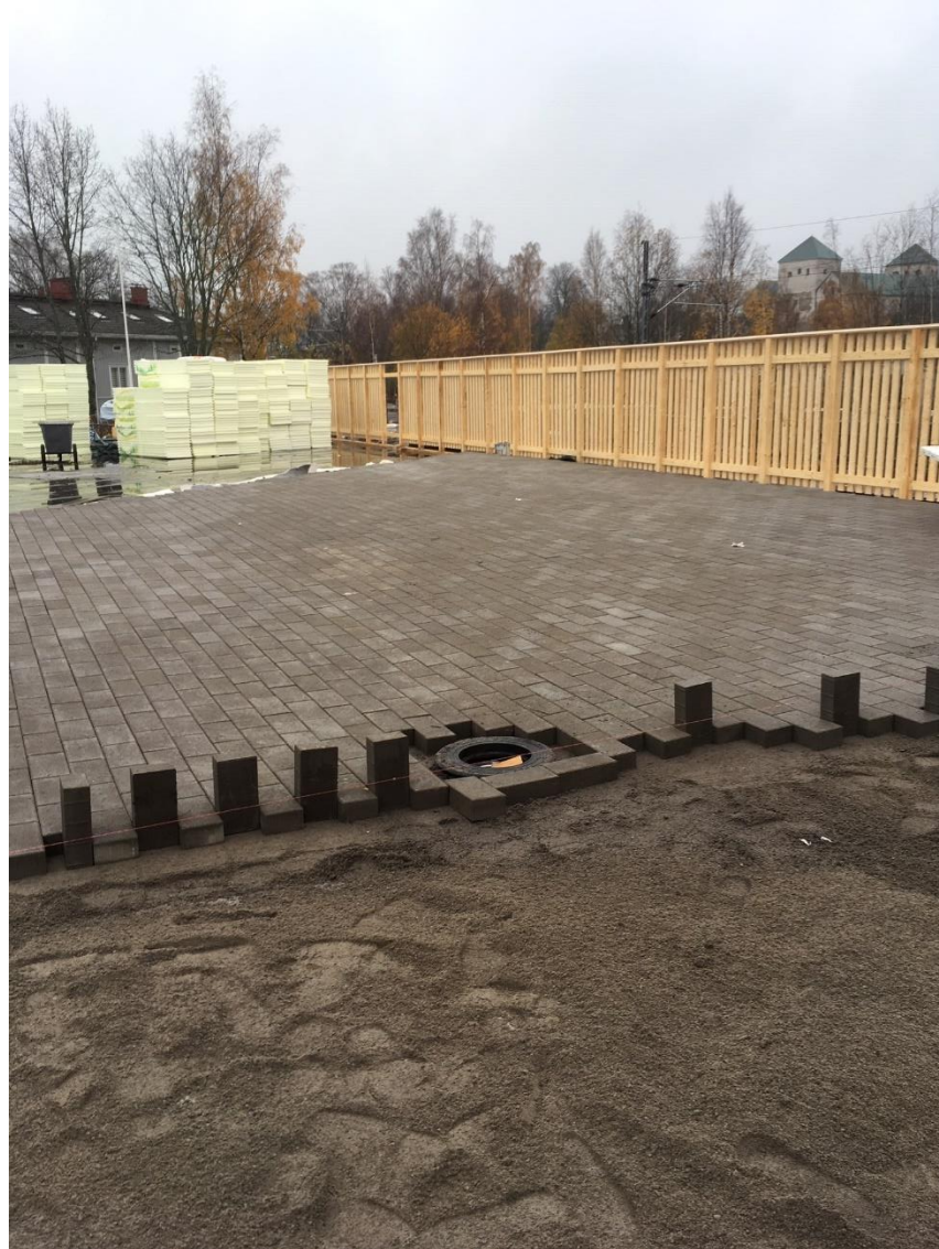
Kuva 3. Pihan laatoitustyöt. Kuvan alueella käytetään tiililadontaa.
