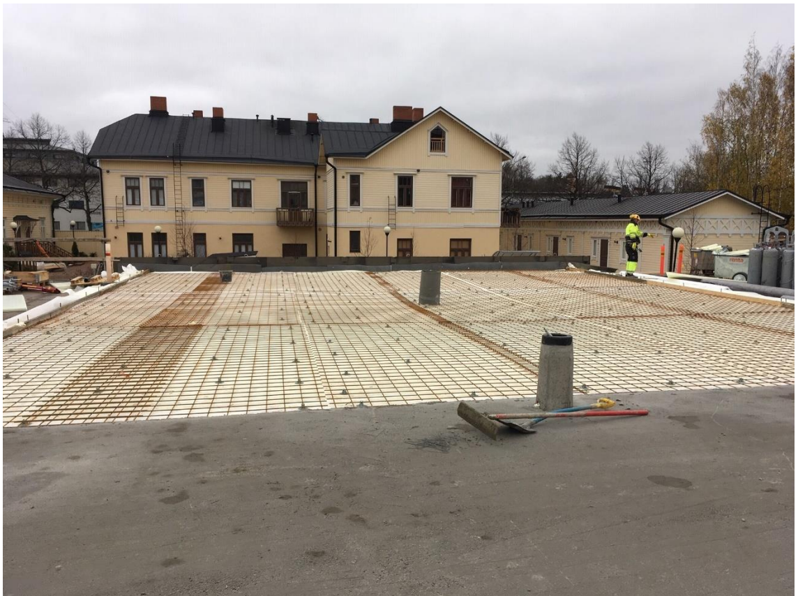
Kuva 2. Alue valmisteltuna valukuntoon. Kuvasta näkyy lisäksi raudoitusverkkojen jakaminen 5 x 5 m:n ruutuihin.
