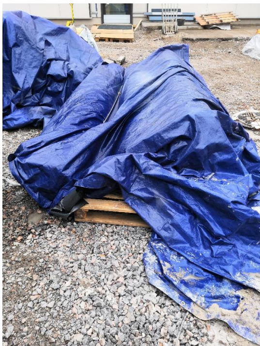
Kuva 11 Rakennusmateriaalien suojaus
