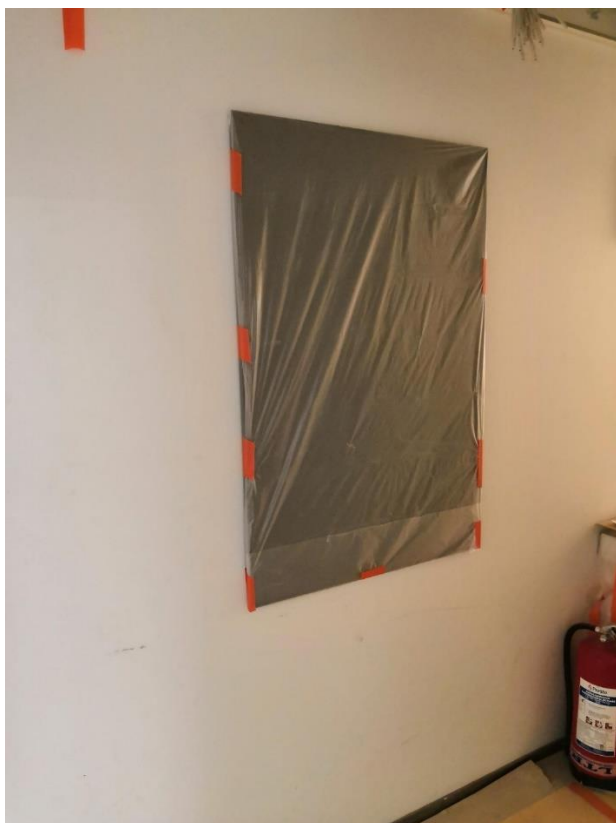
Kuva 7 Kiinnityspinta suojattu muovilla
