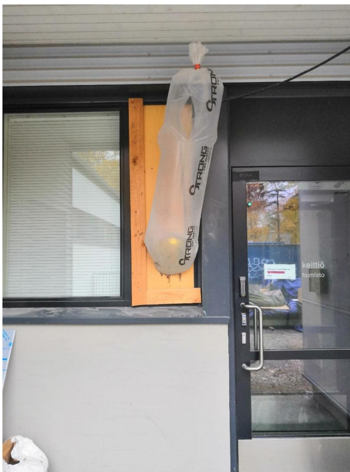
Kuva 8 Alipaineistajan tuloilmaputki
