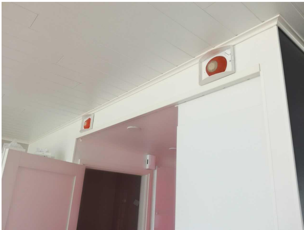
Kuva 4. Ilmanvaihtokanavien pallotus (Hyvönen 2018-07-16).
