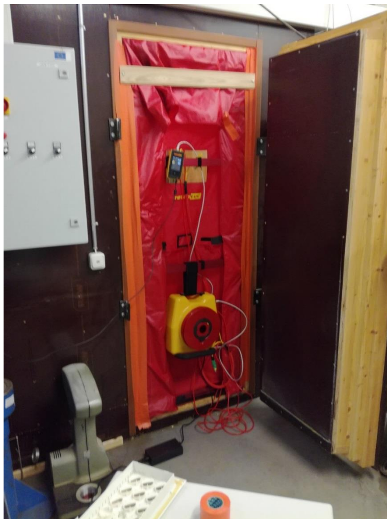
Kuva 3. Puhallin ja kehikko asennettuna oviaukkoon (Hyvönen 2018-02-07).
