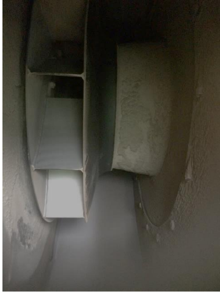
Kuva 13. Savukaasupuhaltimen siipipyörä
