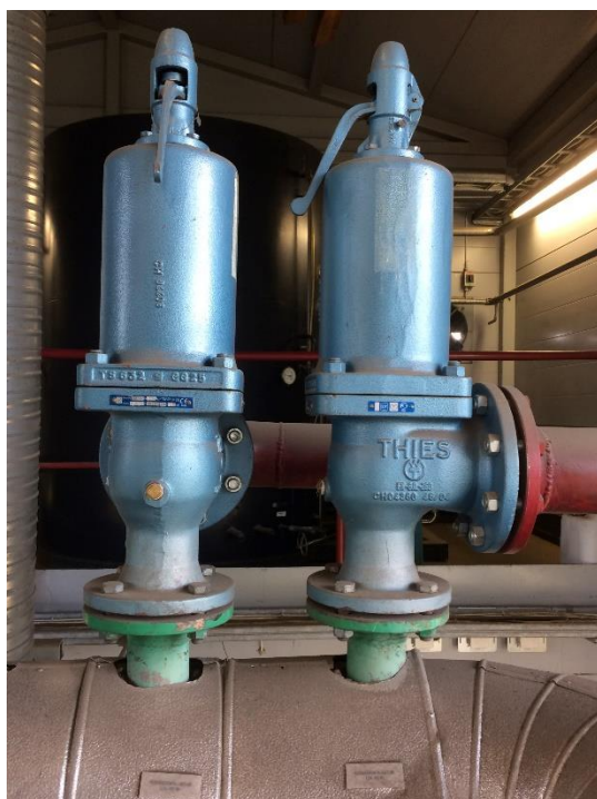
Kuva 15. Jousikuormitteiset varoventtiilit
