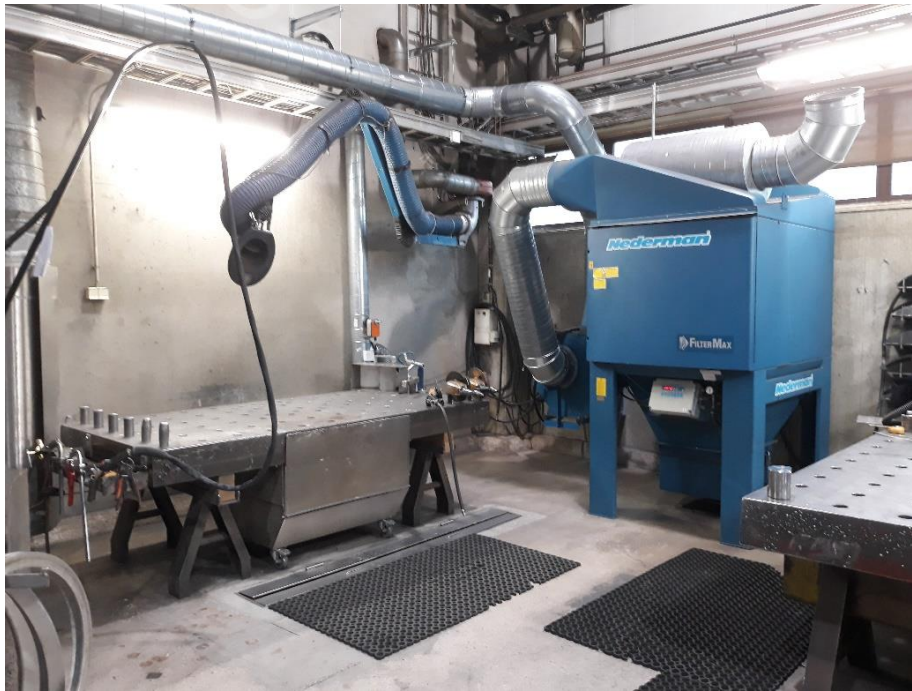
Kuva 15. Renkaan valmistuksen uusi pölynpoistoyksikkö asennettuna
