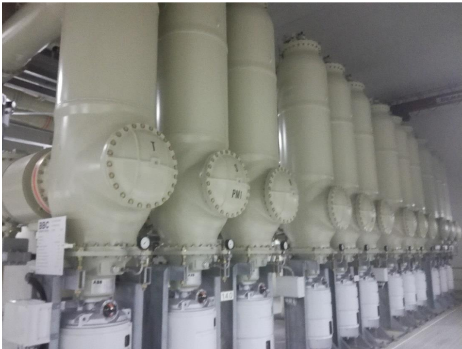
Kuvio 3 GIS-laitoksella oleva laitteisto on koteloitu tiiviisti.
