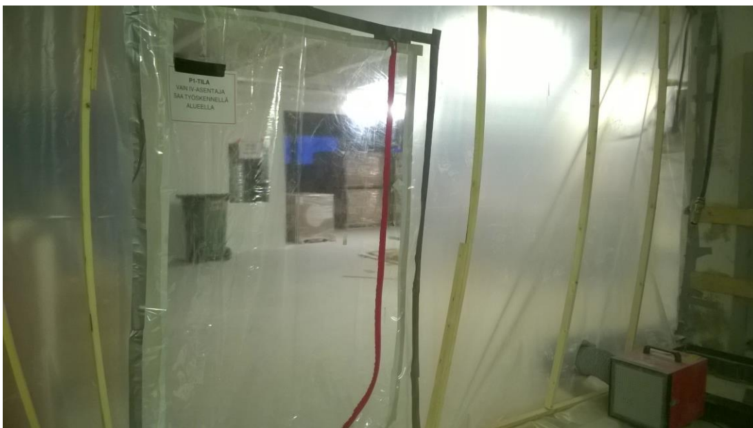
Kuva 5. Osastointia varten tehty suojaseinä.
