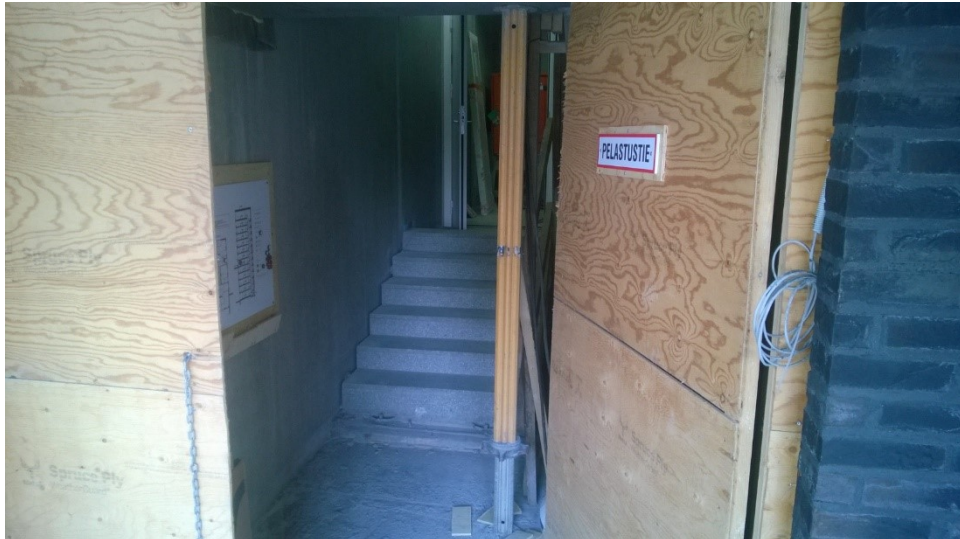
Kuva 11. Palo-osastoidun porraskäytävän väliaikainen ulko-ovi.
