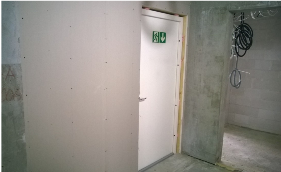
Kuva 10. Väliaikainen paloseinä
