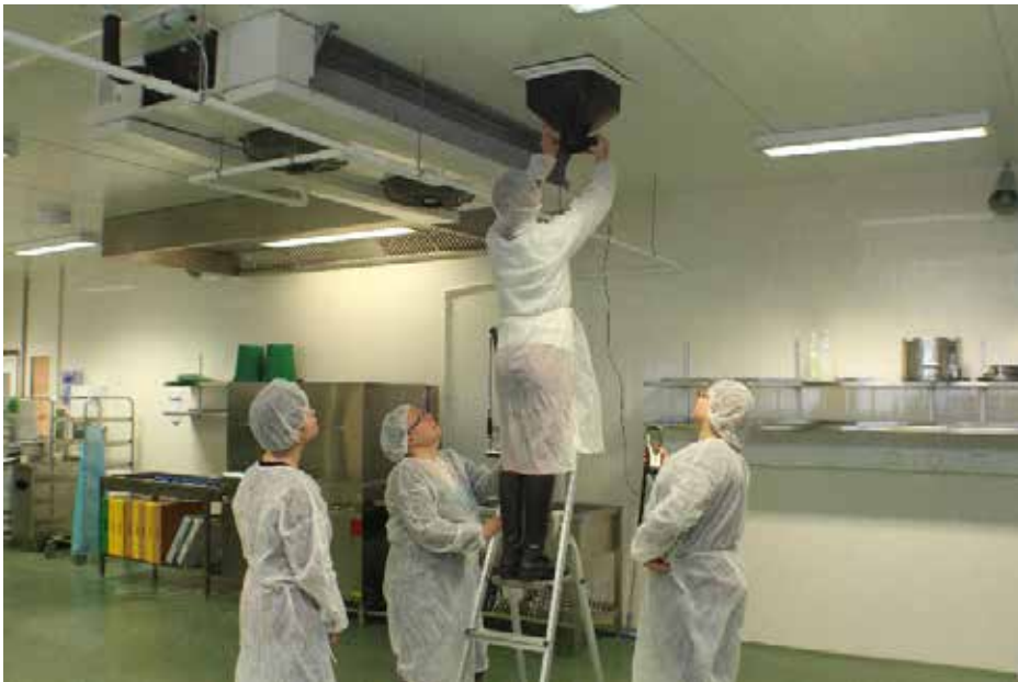
KUVA 4. Ilmanvaihdon virtausnopeuden tarkastelua Testo 435-4 -mittarilla Keskuskeittiö Kapyysissa, kuvassa energiatekniikan insinööriopiskelijoita (kuva Juha Palmu, Kymijoen Ravintopalvelut Oy).
