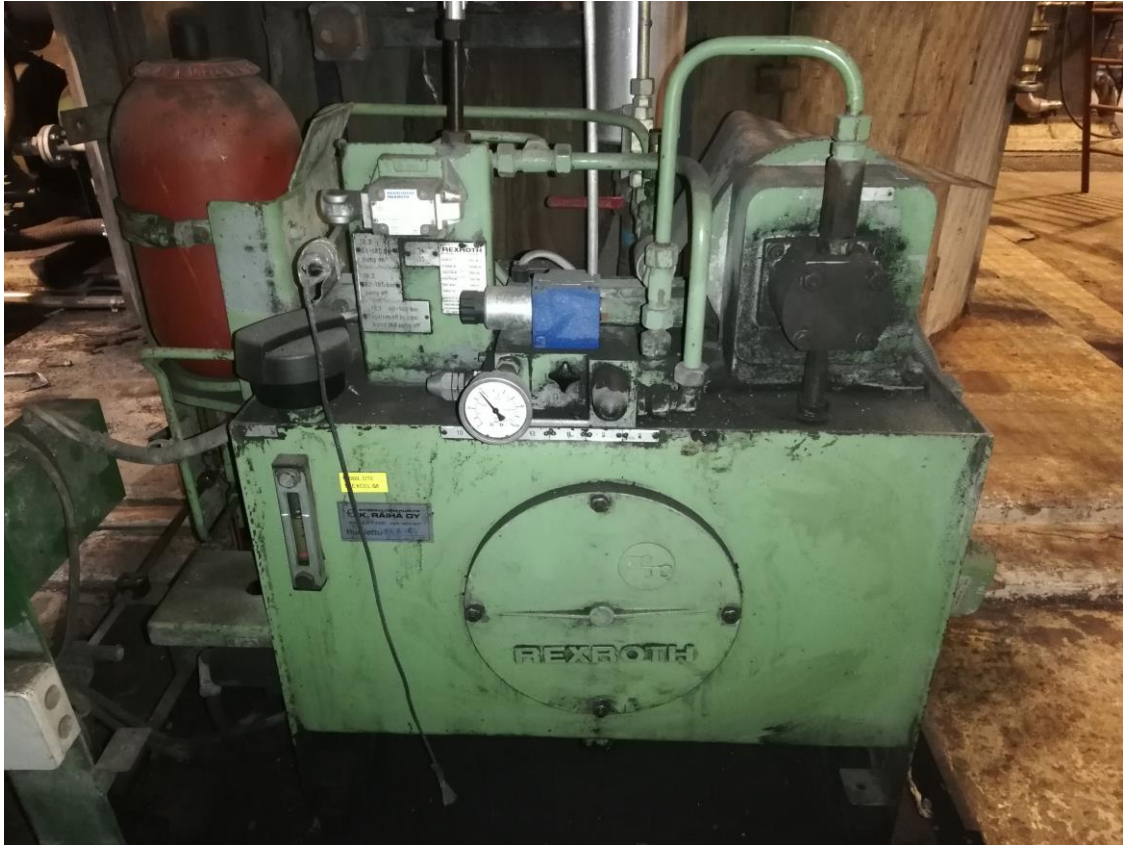
Kuva 14. Hiilimylyn hydraulikoneikko. Taustalla hiilimyly.
