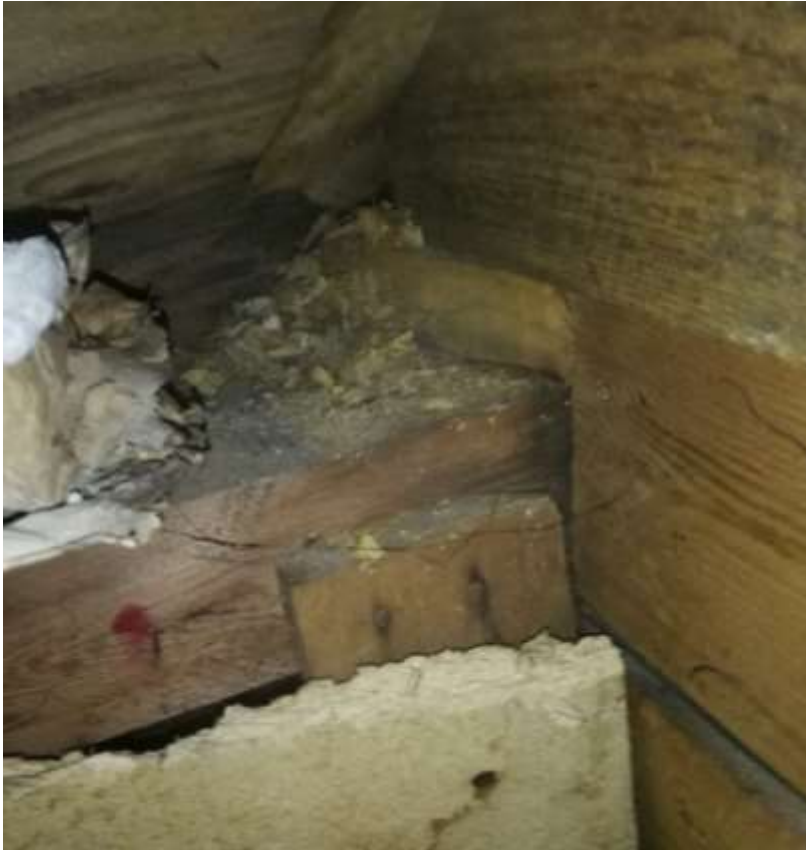
KUVA 3.2. kerroksen varaston ulkoseinä sisältä kuvattuna
