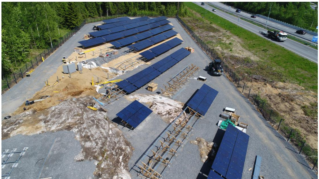
Kuva 7 Mikkelin aurinkovoimala rakennusvaiheessa (Sun Mikkeli)
