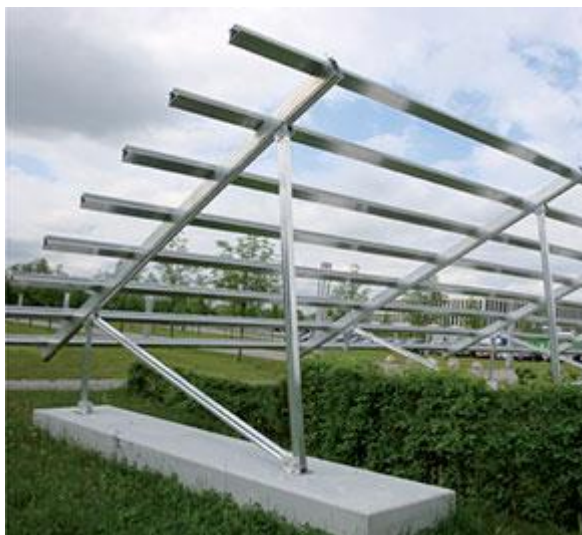
Kuva 3 Betonipainojen päälle asennetut telineet (Schletter).
