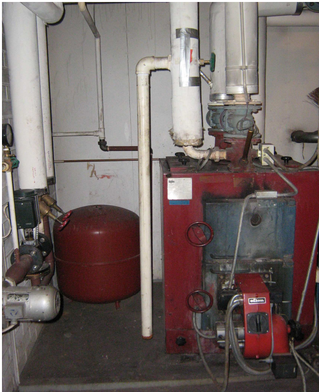
Kuva 2 2.1.1 kattila, poltin ja kalvopaisunta-astia
