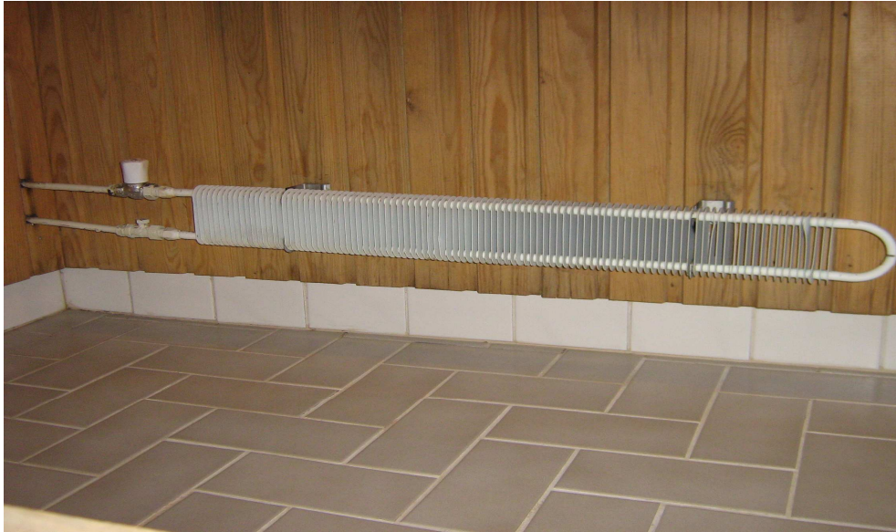
Kuva 3. 1. Lämpimään käyttövedeen kytketty kiertovesipatteri
