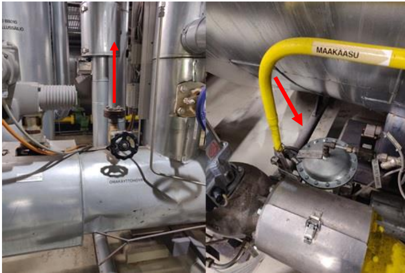
Kuva 31. Omakäyttöhöyrytukin yhde ja apukattilan pohjapuhallusputki
